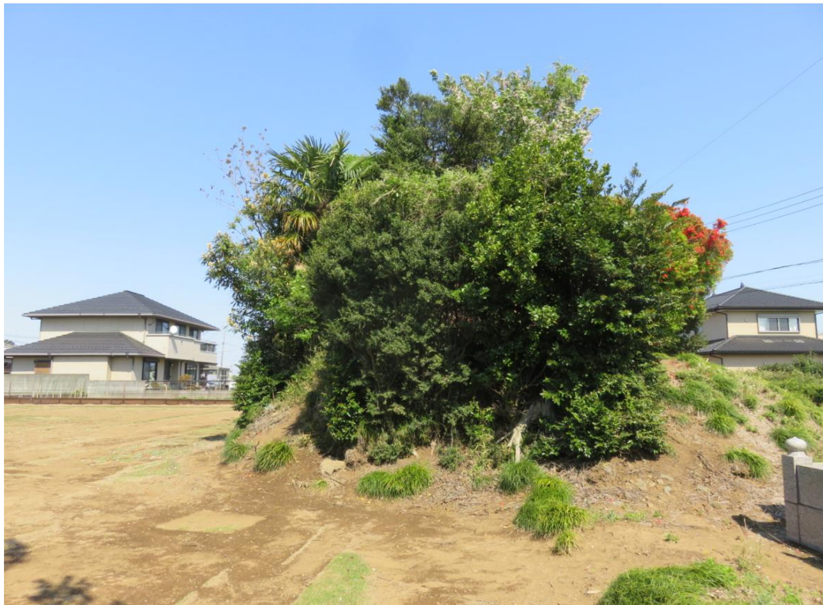
西側から見たところ
