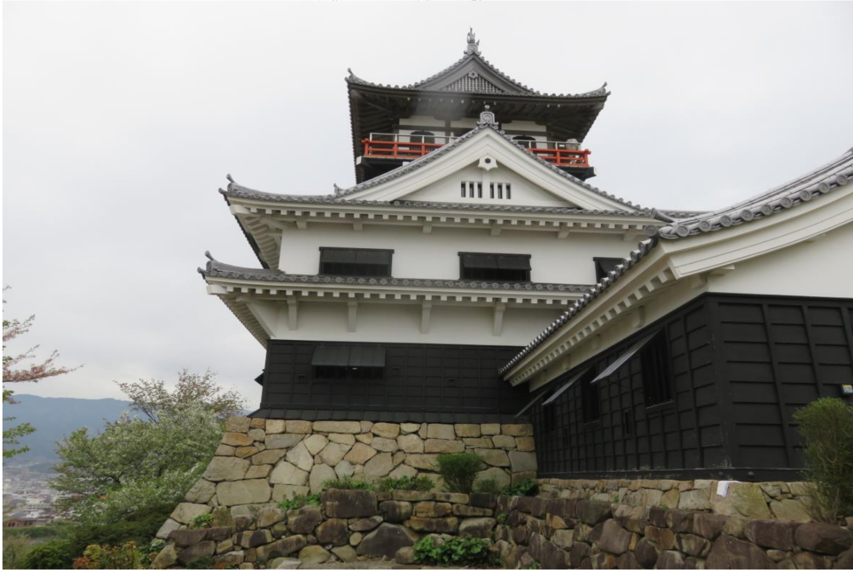
隅櫓付近から天守閣(北面)を見たところ
