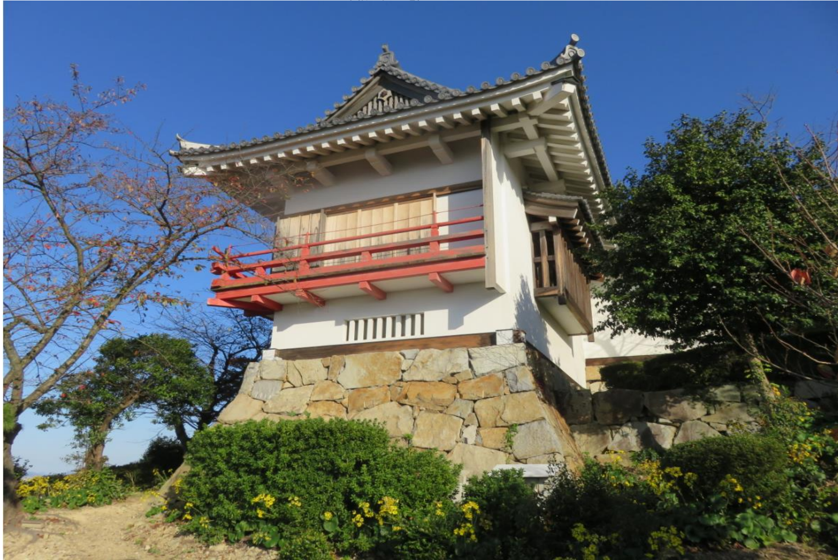
涼檜の妻面を見上げたところ
