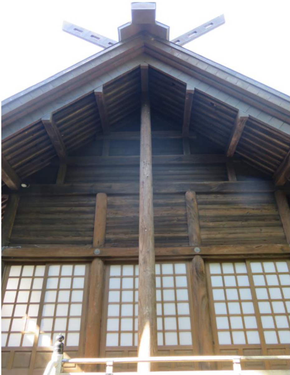
棟持柱が立つ拝殿
