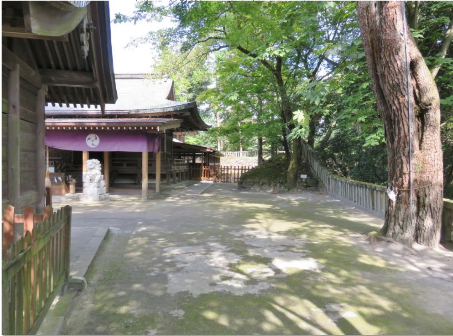
社殿の右側を南側から北方向に見たところ/正面が土塁
