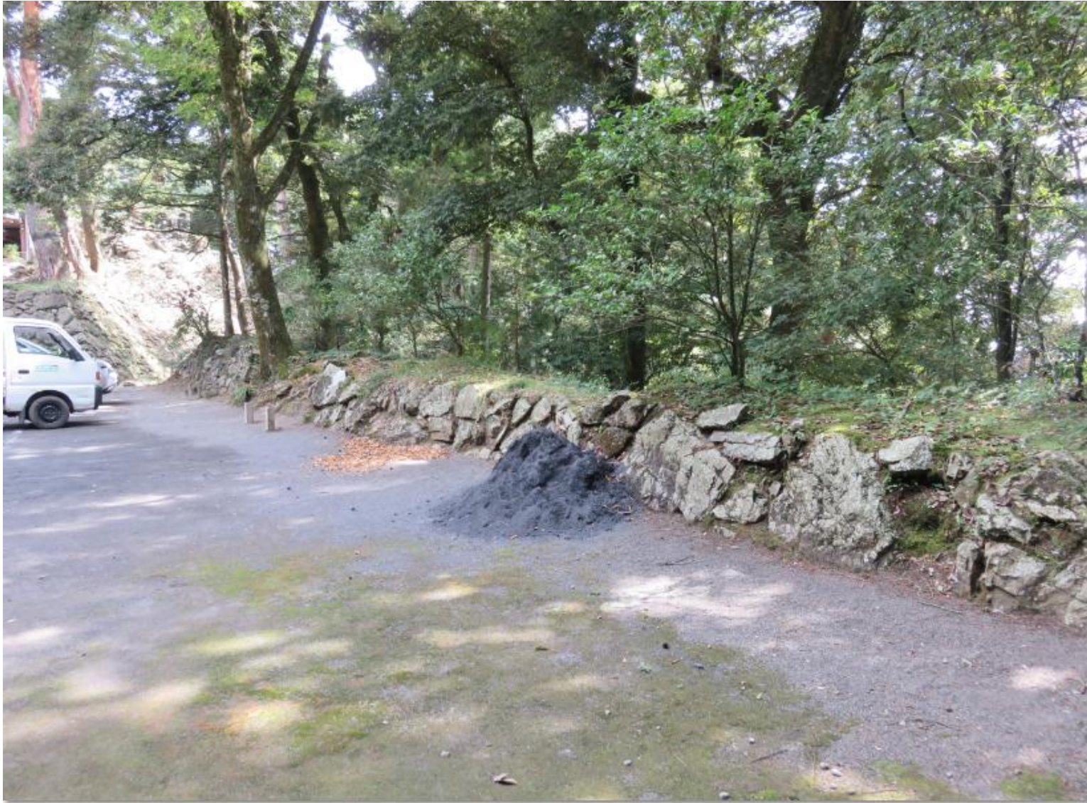
右手の土塁を見たところ
