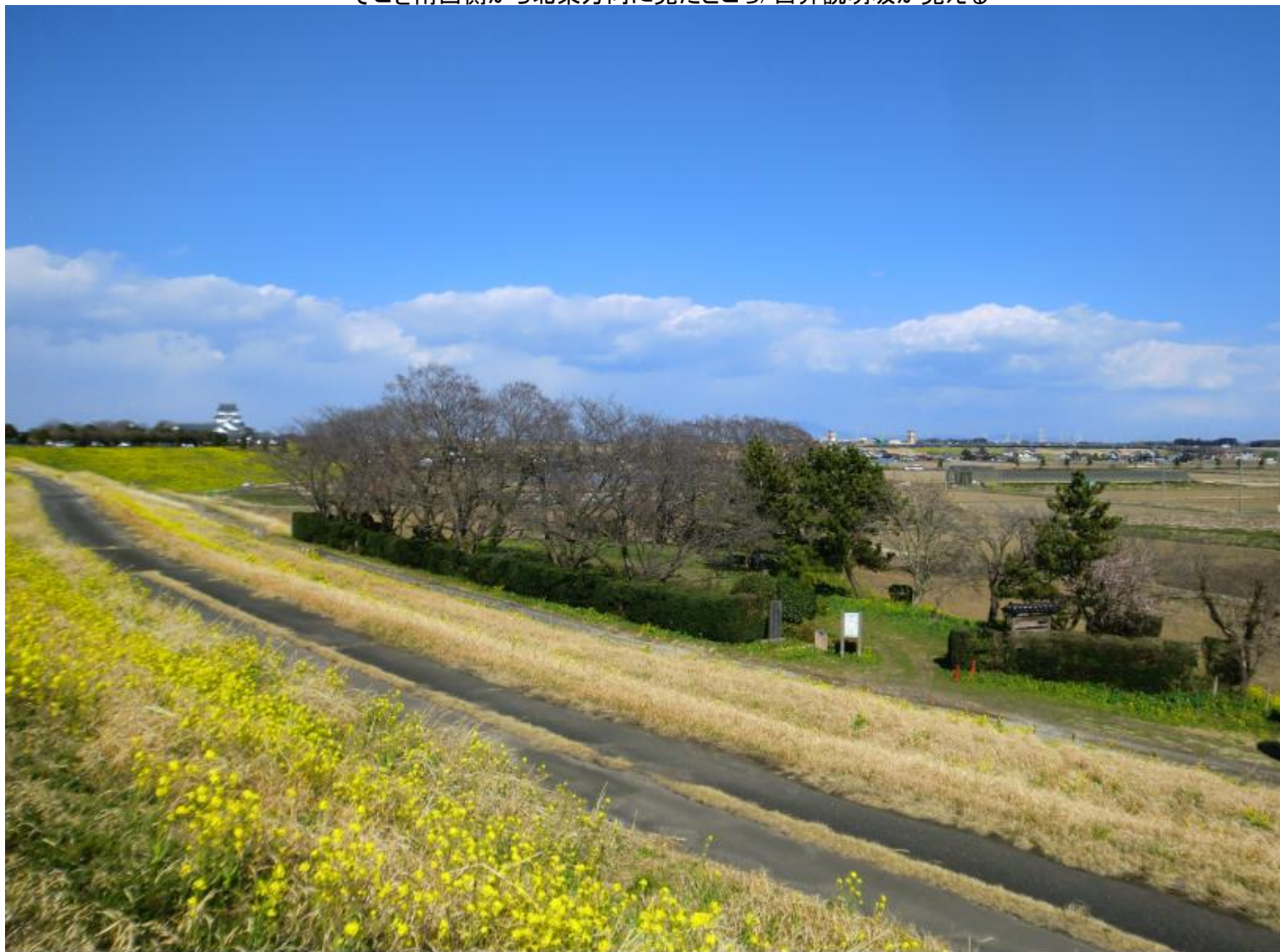
そこを南西側から北東方向に見たところ/白井説明坂が見える
