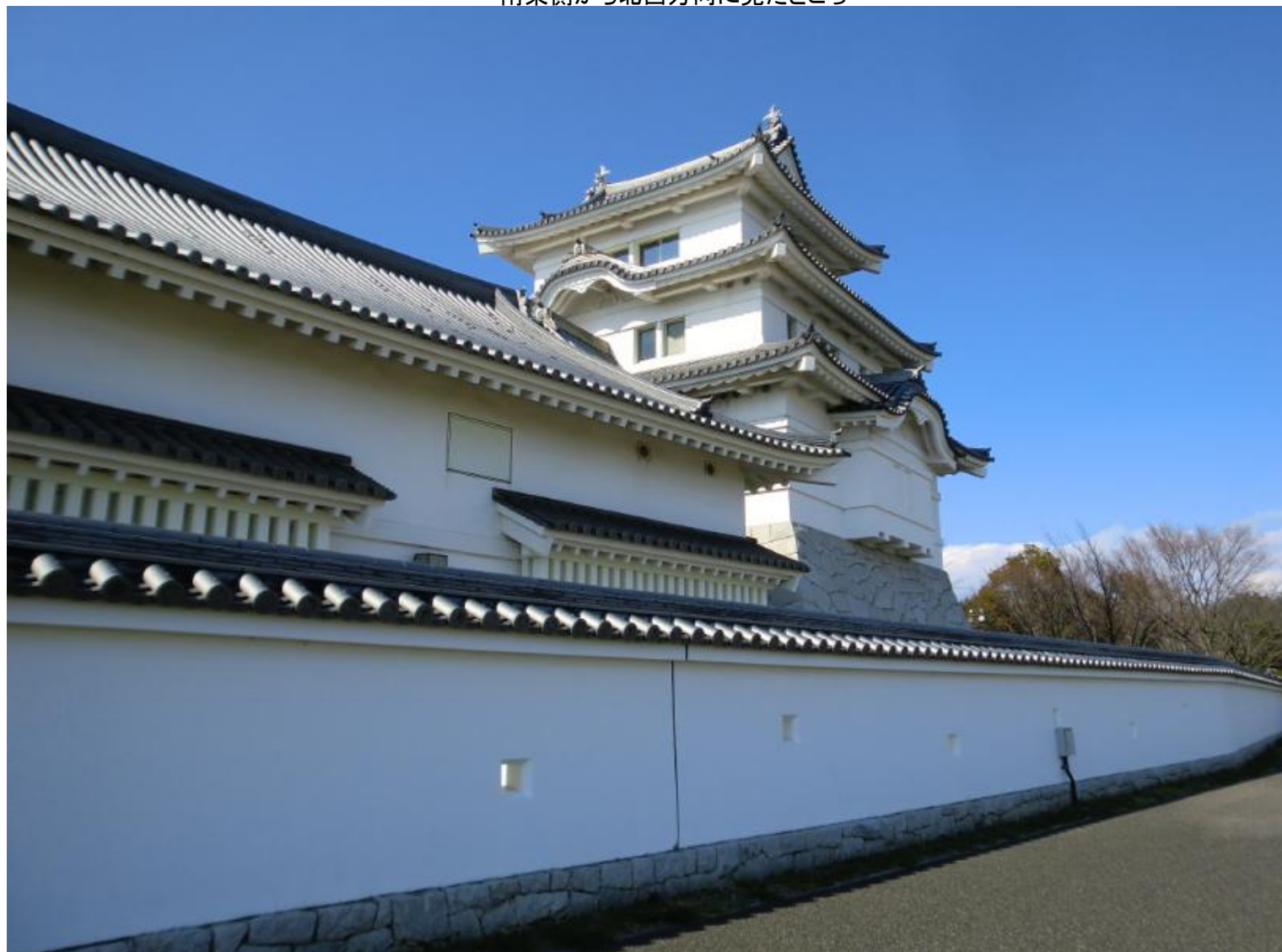
南東側から北西方向に見たところ
