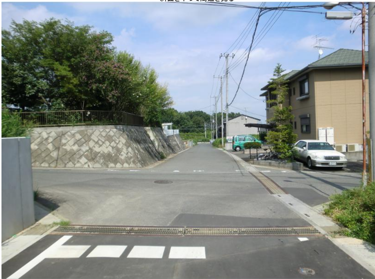
斜面を下って周辺を見る
