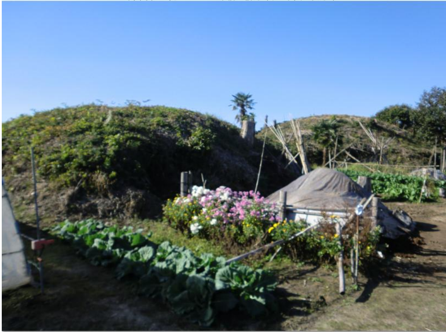
南東側から見たところ/左手前が前方部、右手奥が後方部
