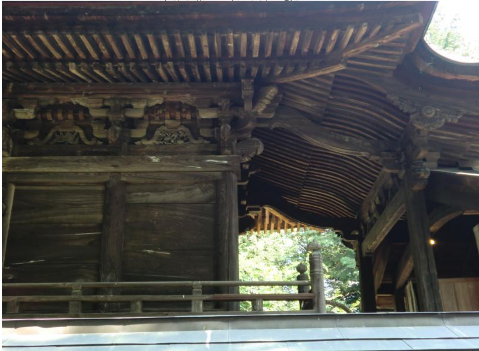
本殿と渡殿との屋根の取り合いを見たところ
