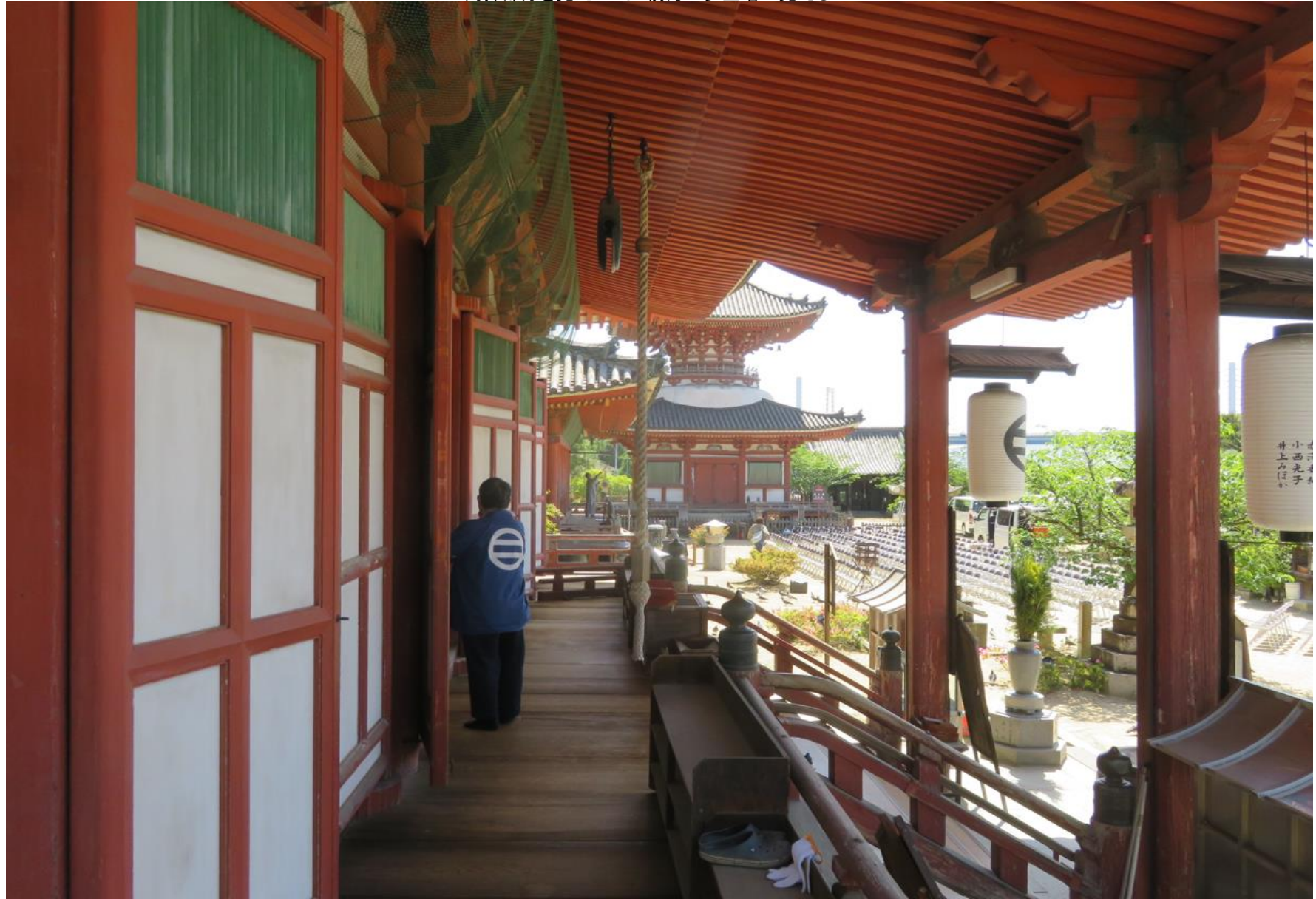
向拝部分を見たところ/前方に多宝塔が見える
