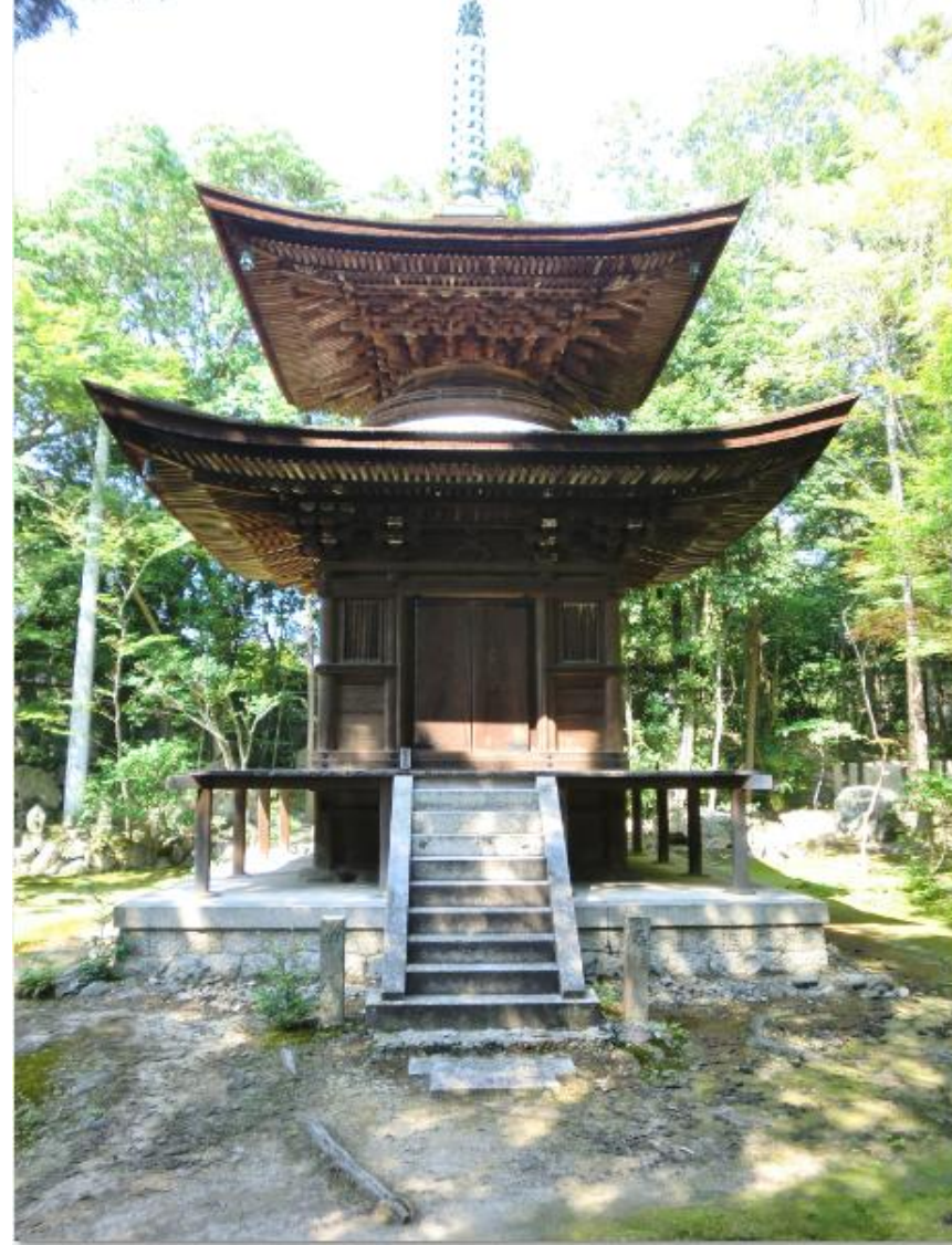
明治時代になって金堂脇から移築され、基壇の上に建っている
