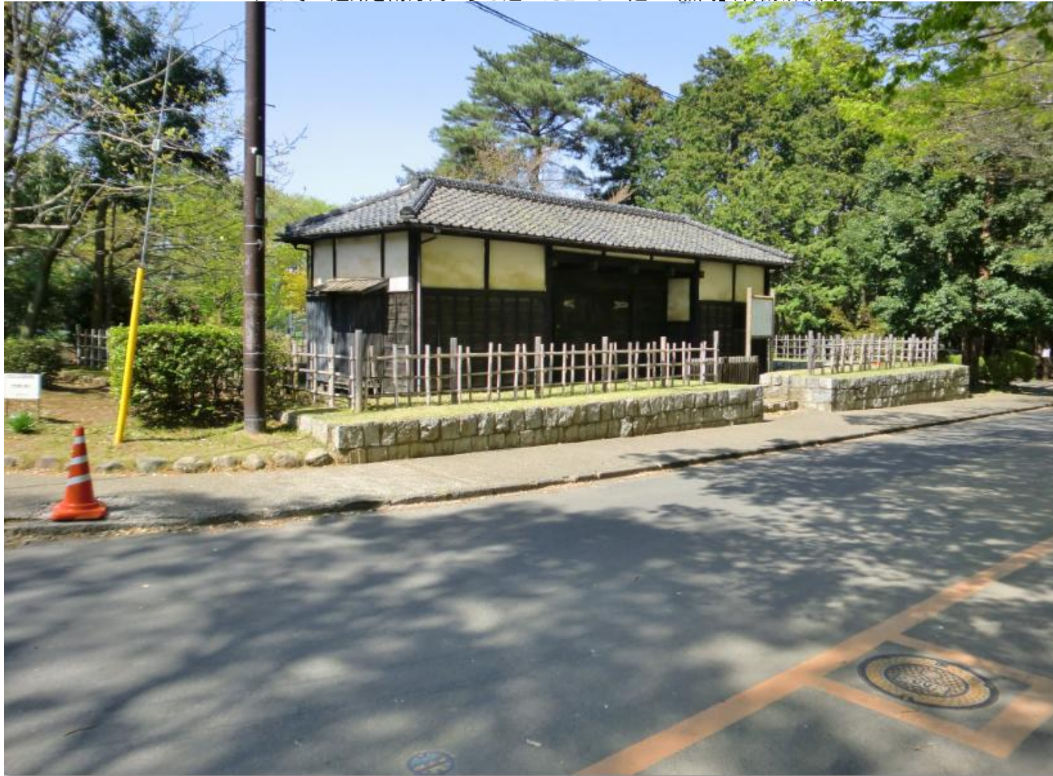
これはその道路を南方向に少し進んだところに建つ「黒門」(岩槻城城門)
