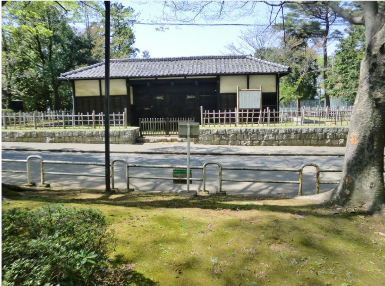
南側から見たところ
