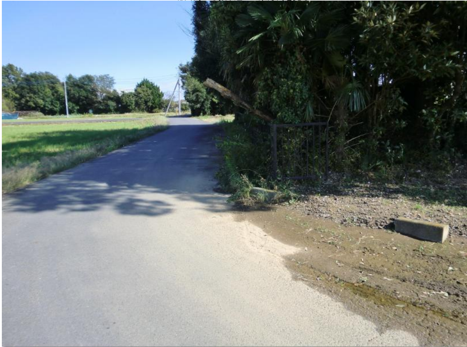
北西角から振り返って東方向を見る
