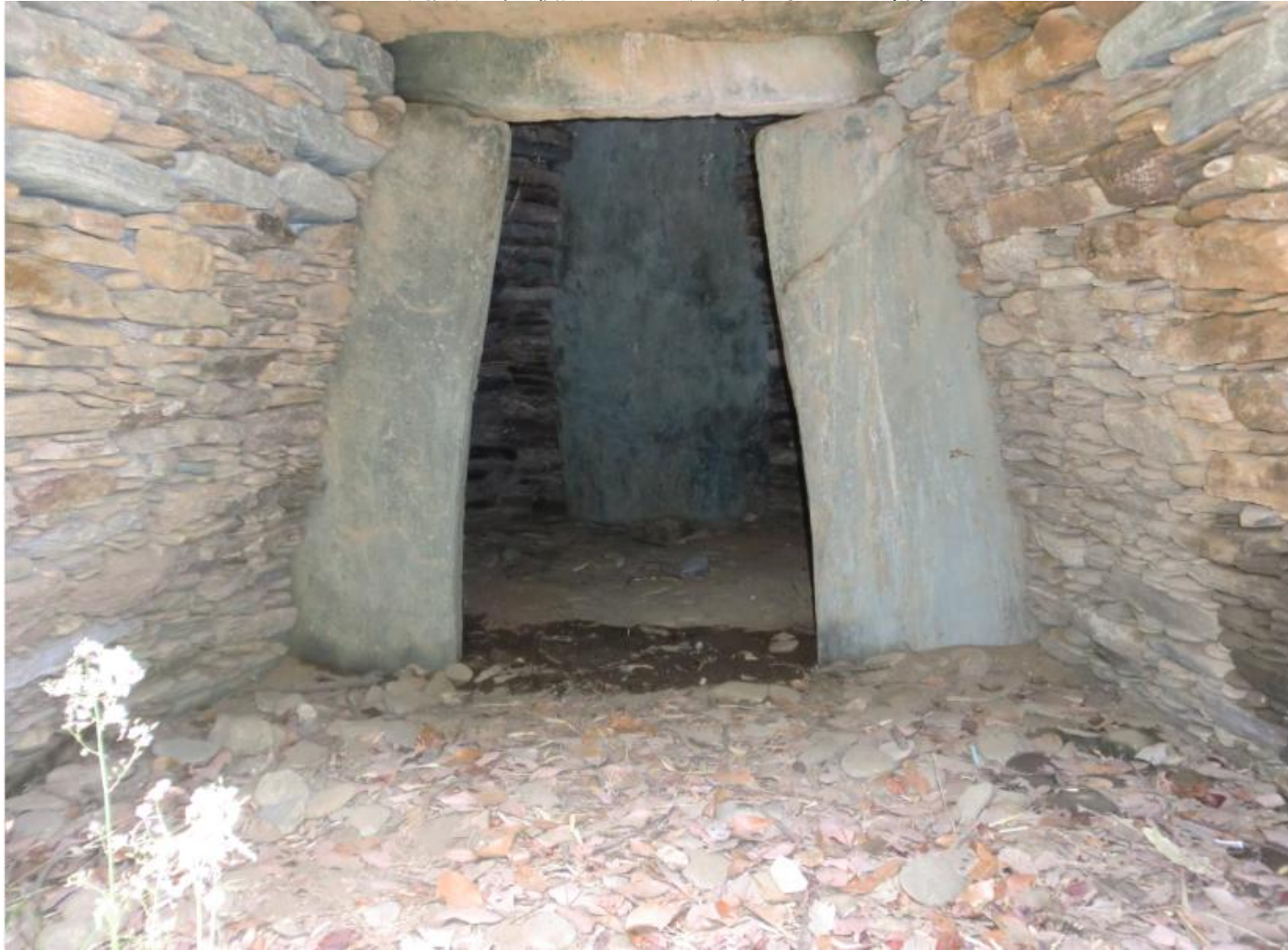
石室の横壁がカーブを描いている(中間で膨らんだ形)
