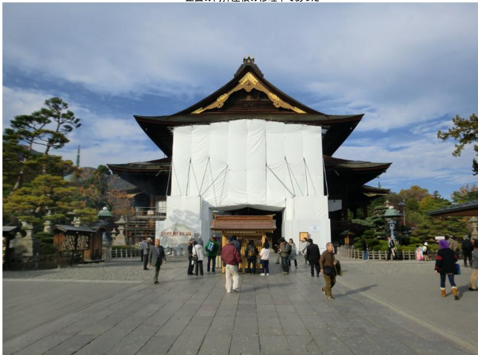
正面の向拝屋根の修理中であった
