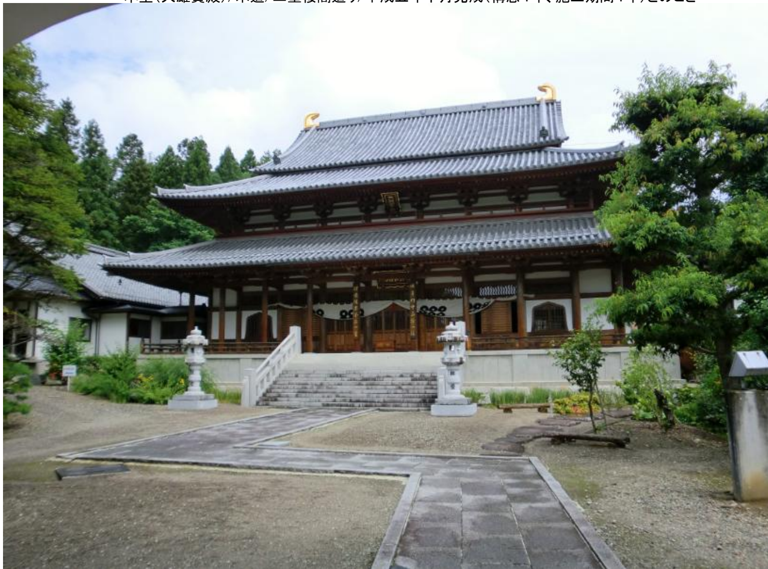
本堂(大雄寶殿)/木造/二重樓閣造り/平成五年十月完成(構想4年、施工期間4年)とのこと
