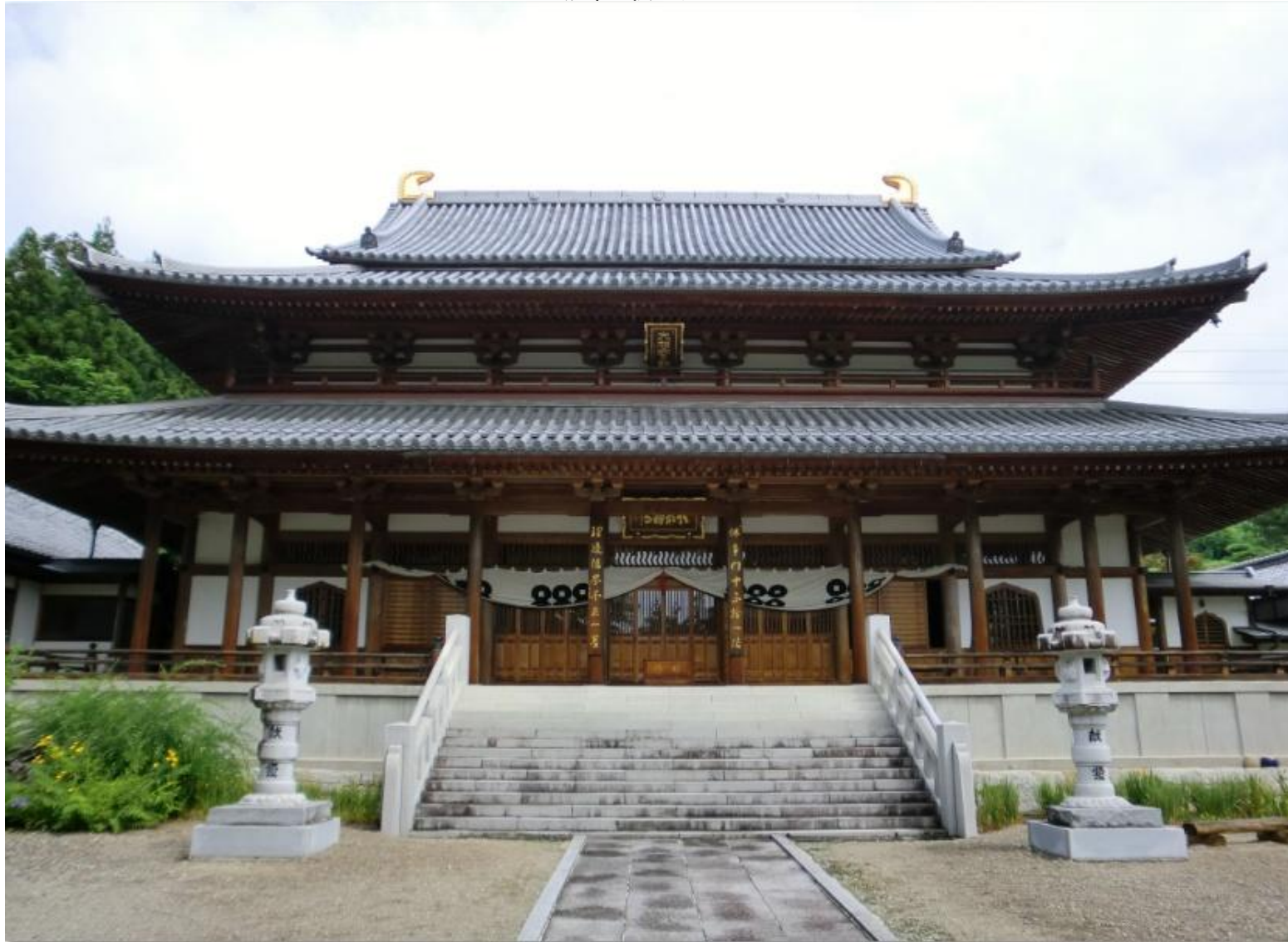
鍔葺屋根となっている
