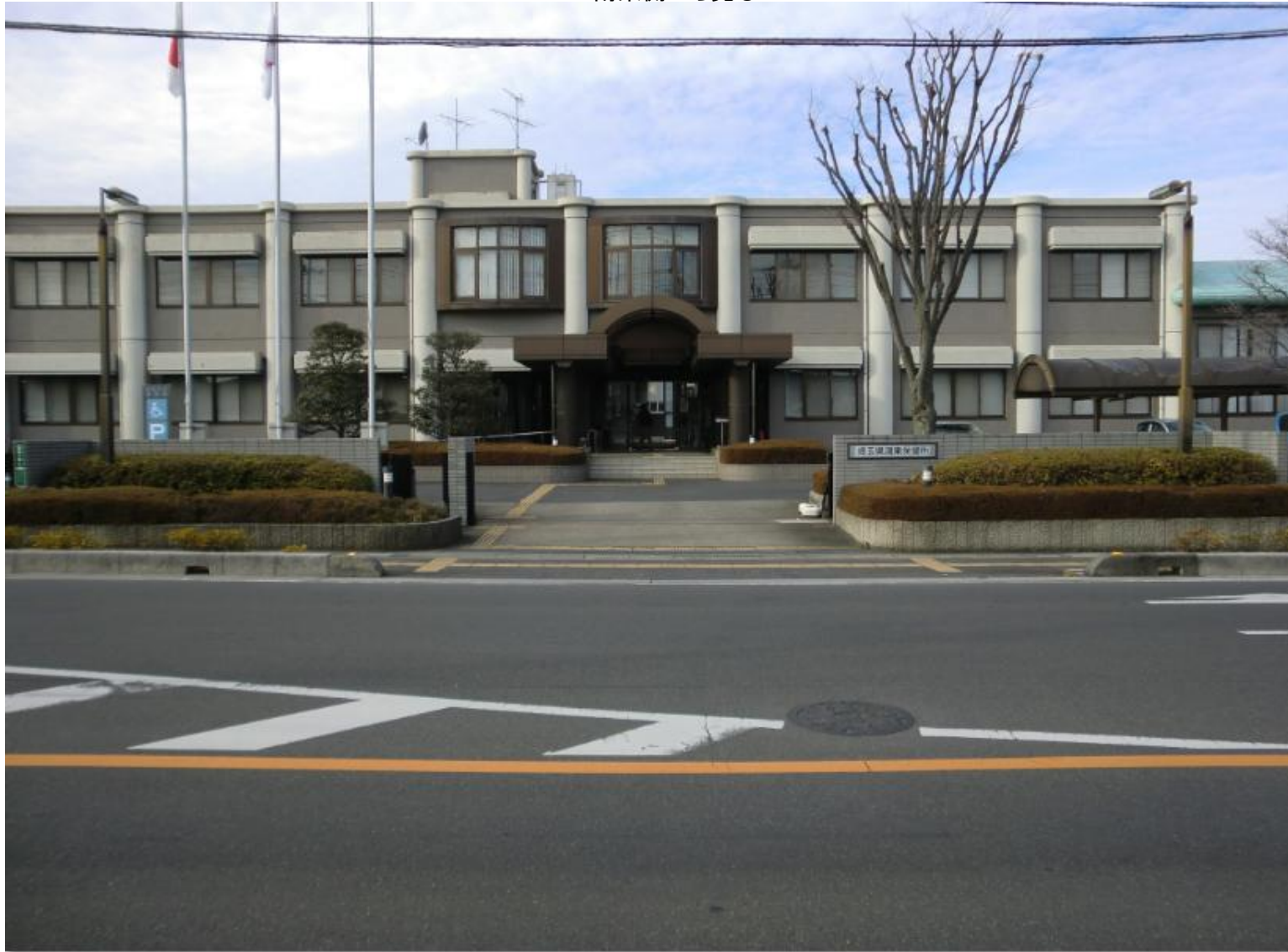
南東側から見る
