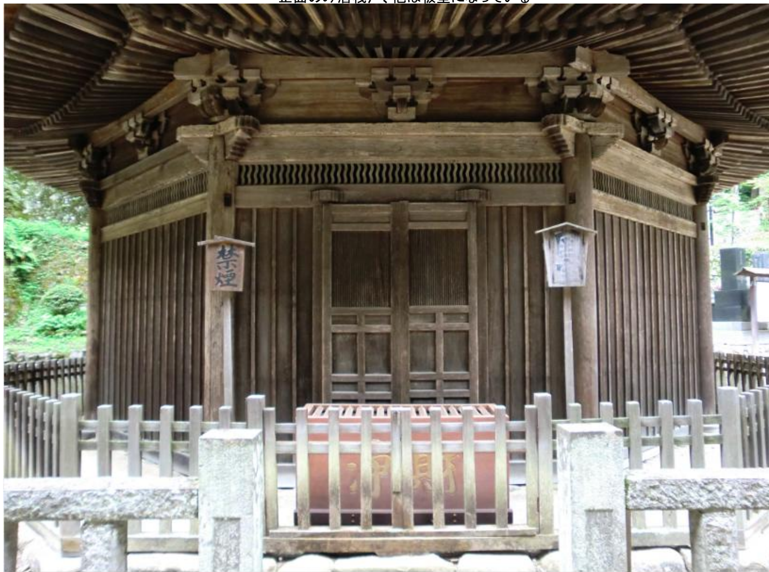
正面のみ唐棧戸、他は板壁になっている
