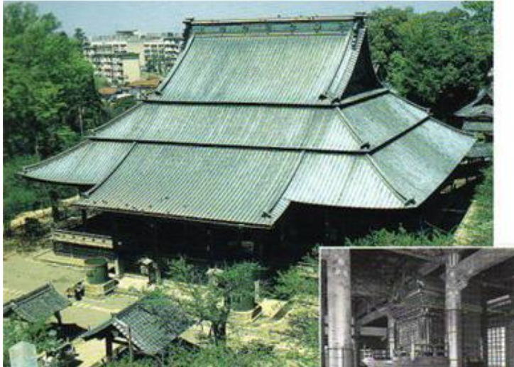
改修前の祖師堂
