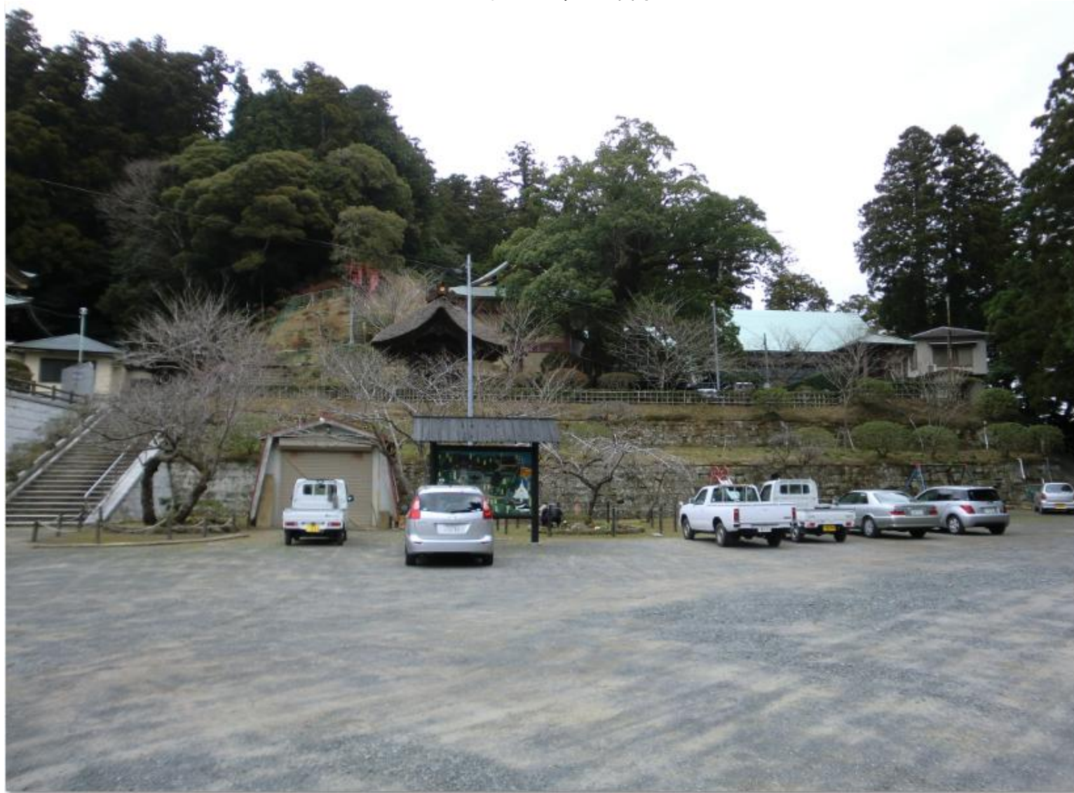
正面の萱葺きは中門
