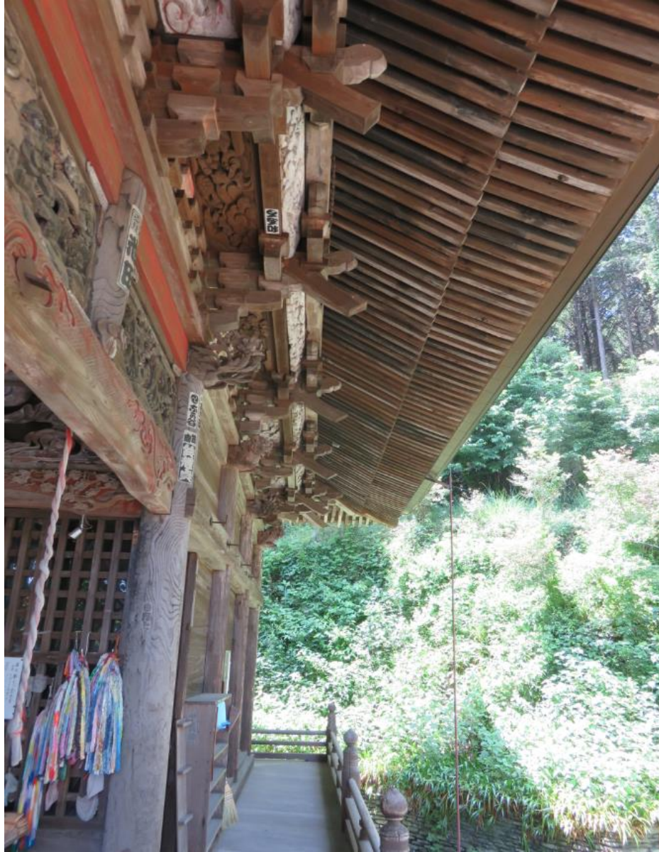
大屋根右手の軒下を見たところ
