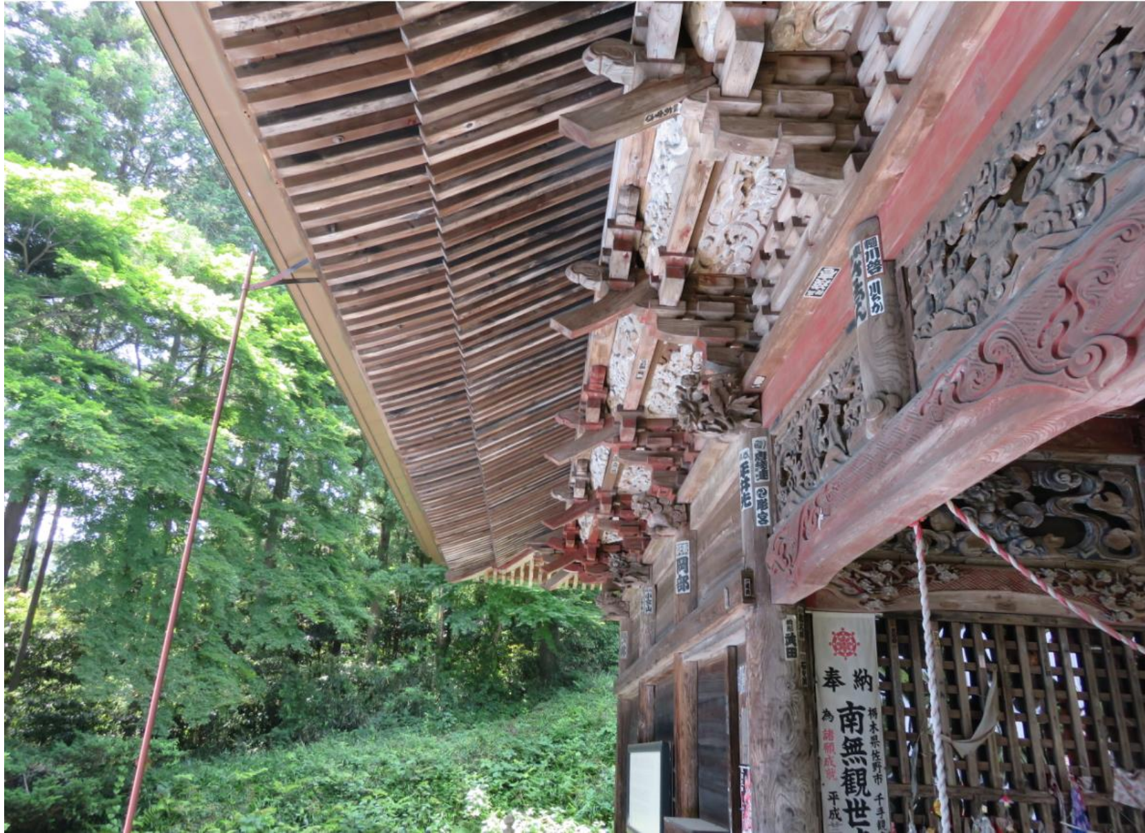
大屋根左手の軒下を見たところ/軒は二重繁垂木/組物は三手先斗拱となっている
