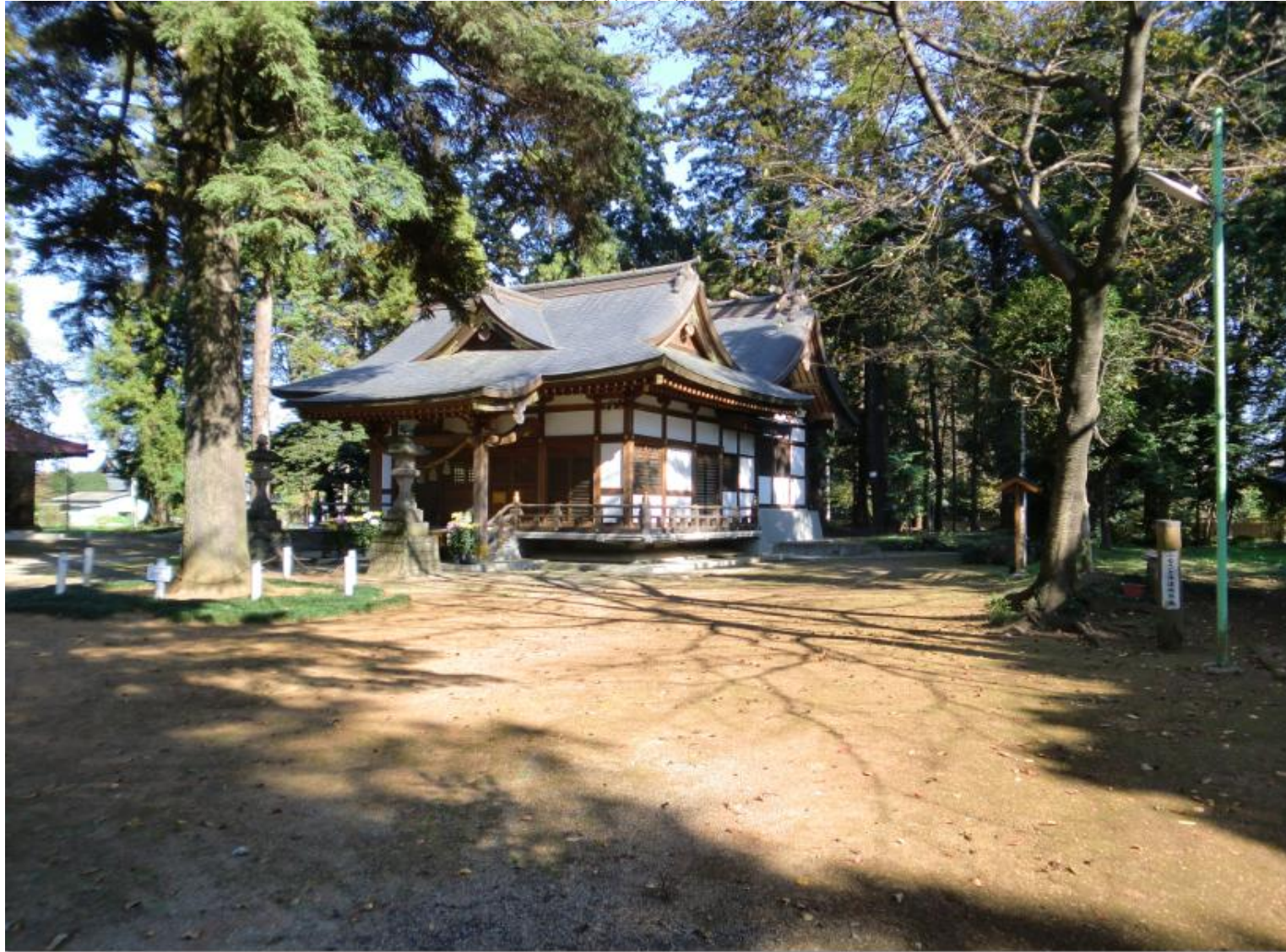
拝殿と本殿(奥)
