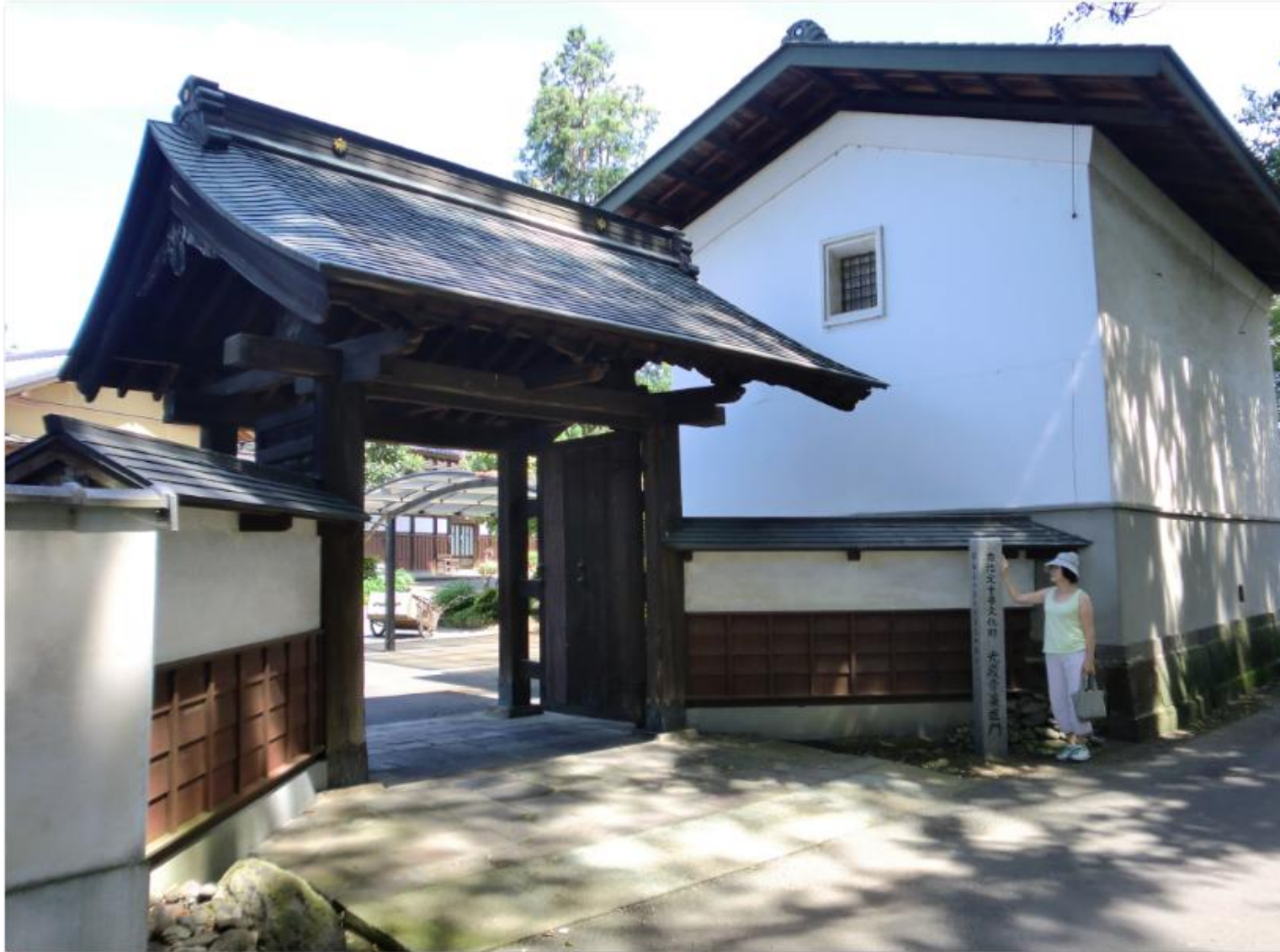
薬医門/江戸時代初期に総社城の門だったものを移築したと推定される/前橋市指定重要文化財
