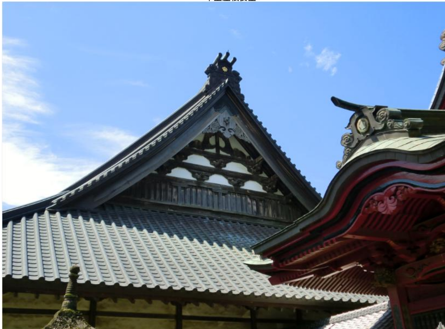
本堂屋根妻壁
