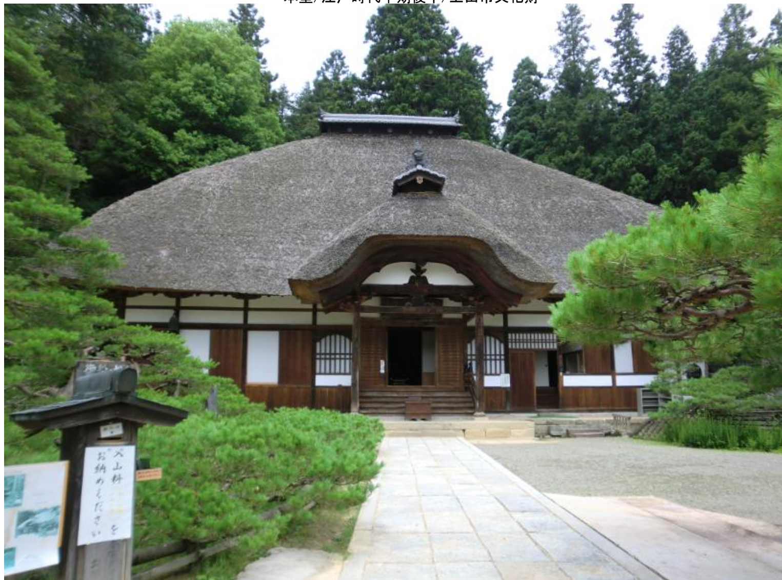
この屋根もこの地域独特？なのか変わった形をしている(他の寺院の屋根参照)
