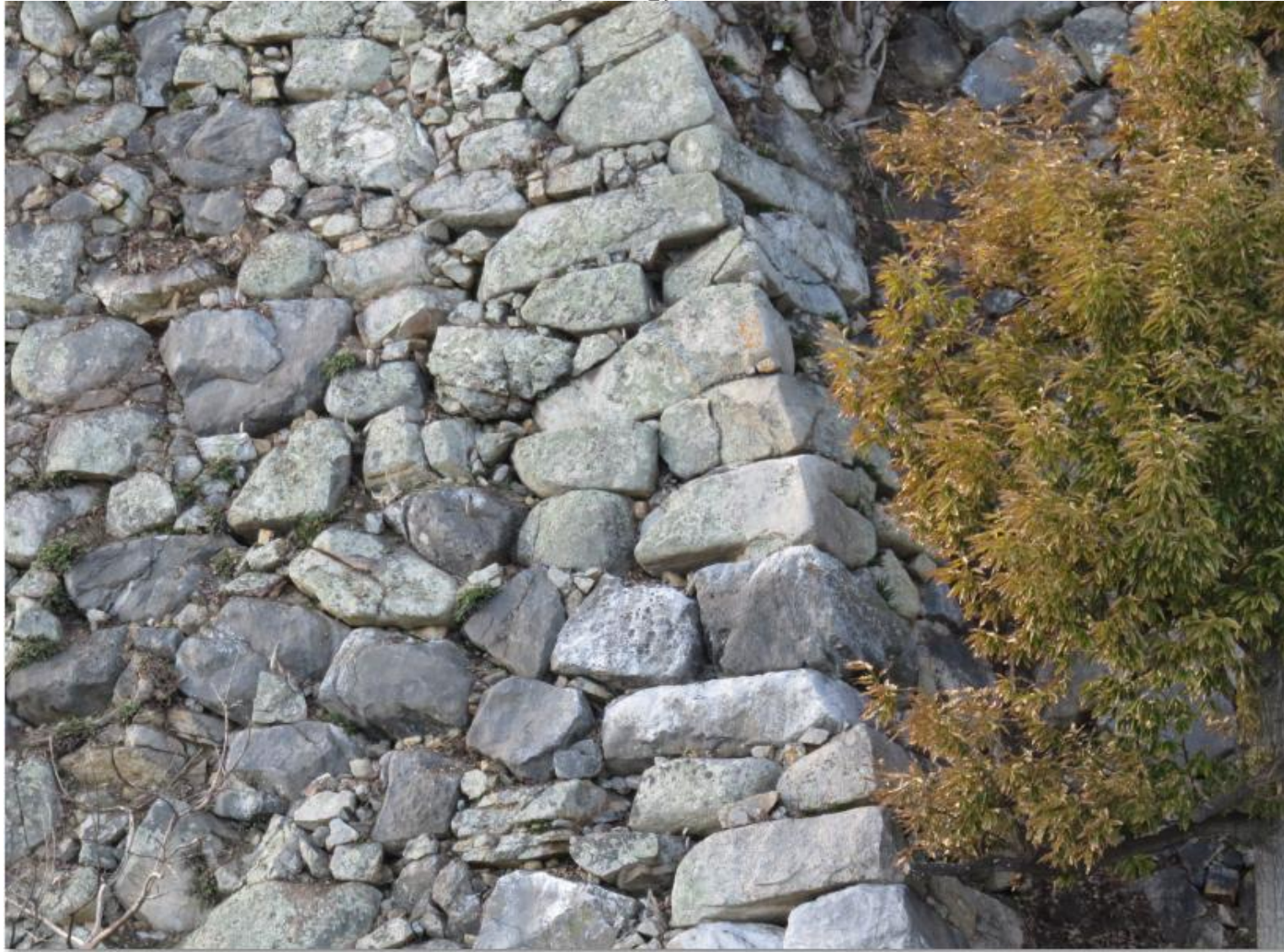
その石垣を見たところ
