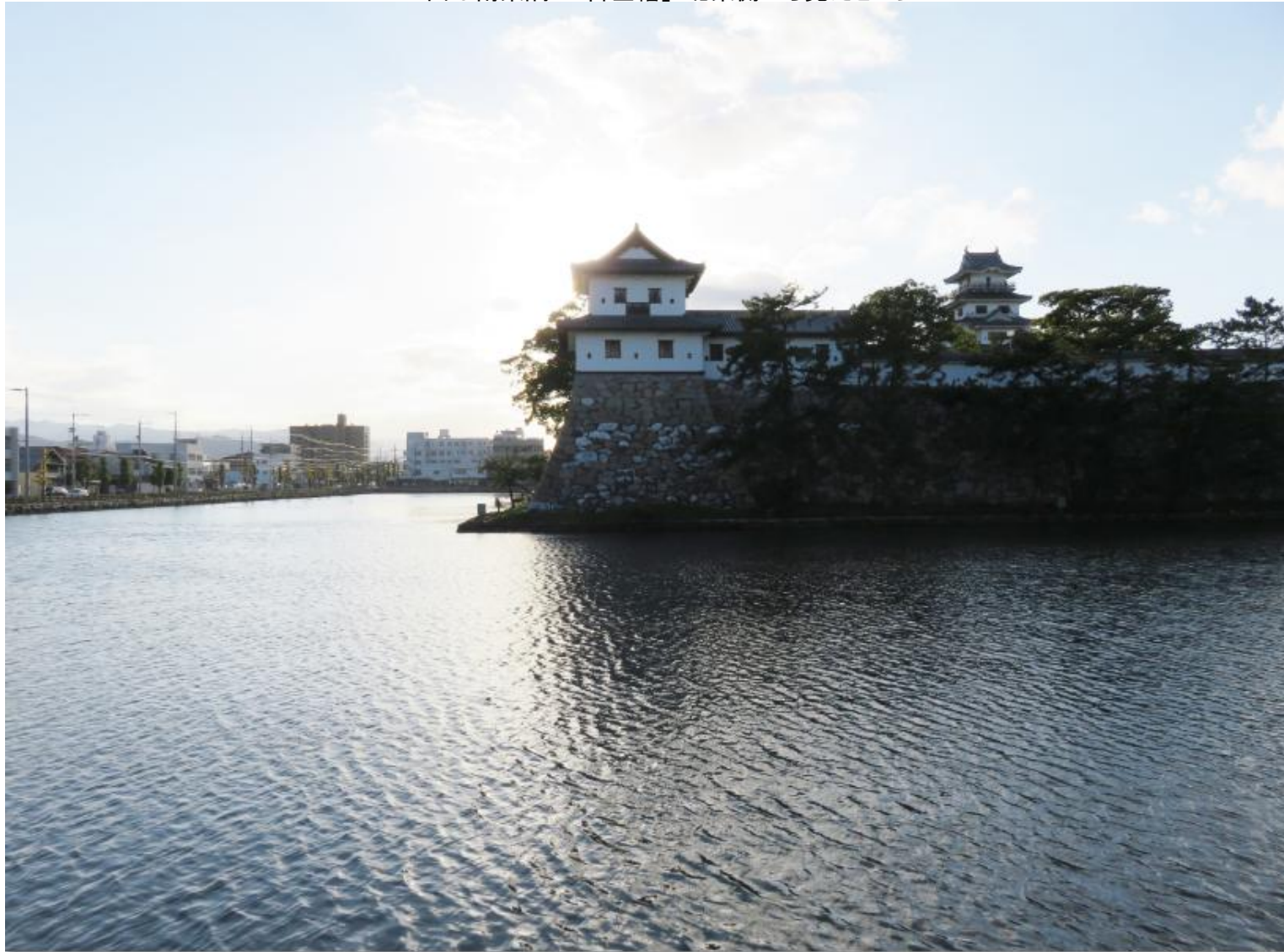
正面は南東隅の「御金櫓」/北東側から見たところ
