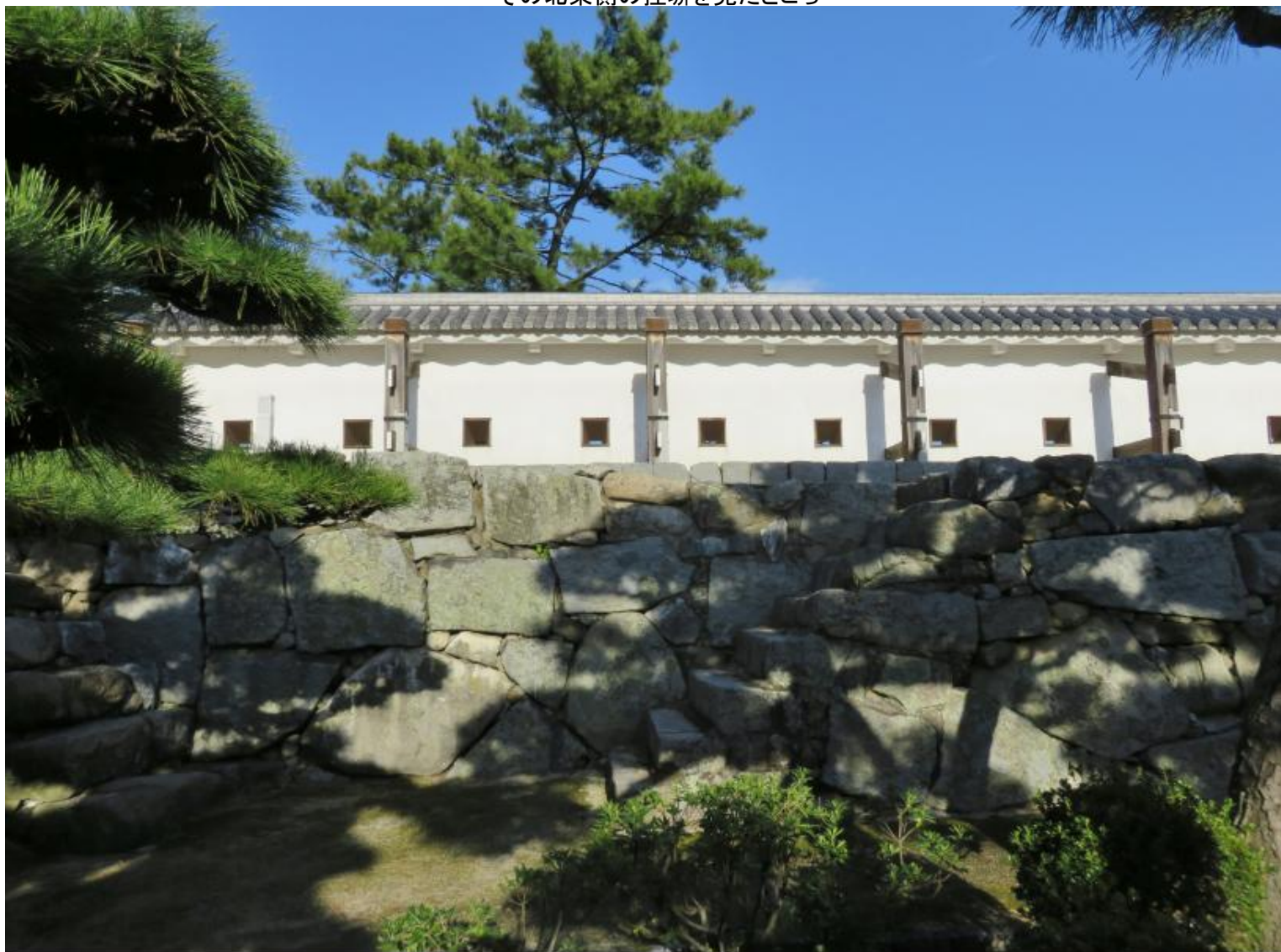
その北東側の控塀を見たところ
