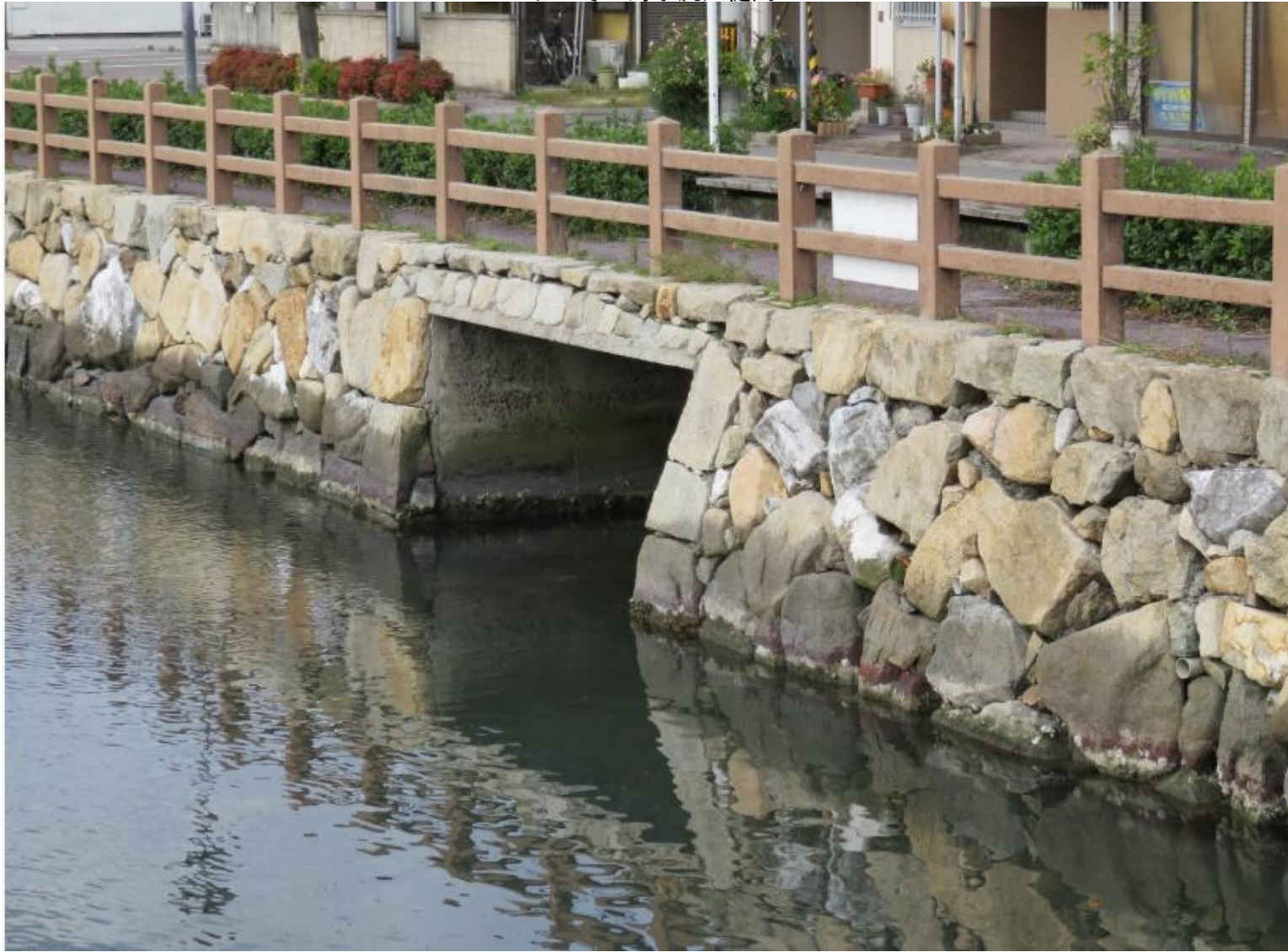
これがその海水流入樋門
