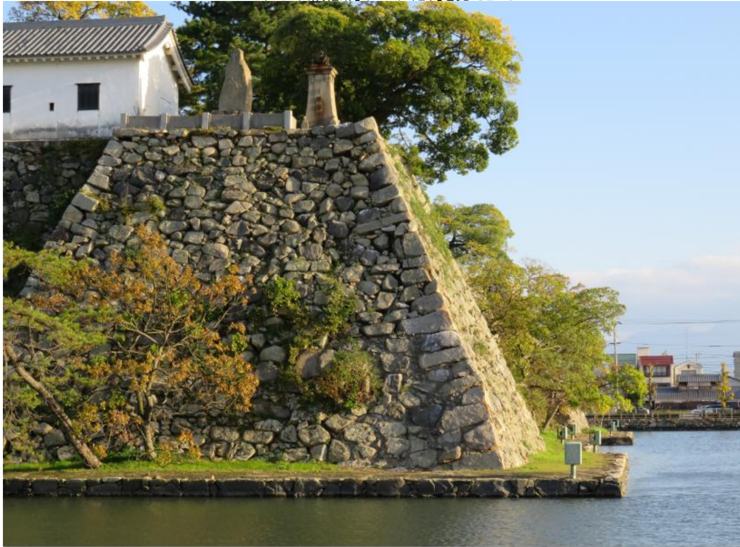
これは「西隅櫓跡」下の「犬走り」を見たところ
