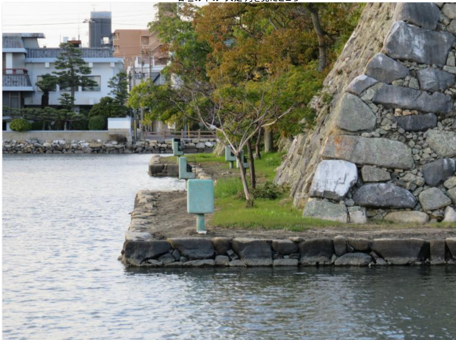
石垣の下の「犬走り」を見たところ
