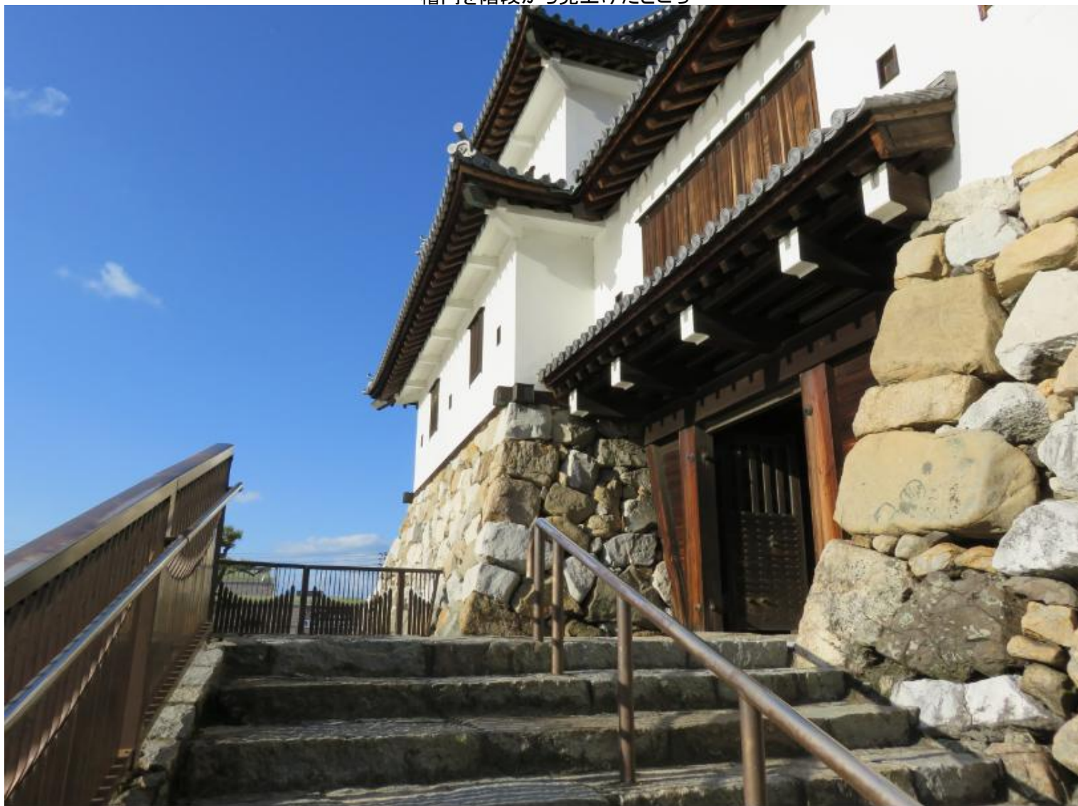
櫓門を階段から見上げたところ
