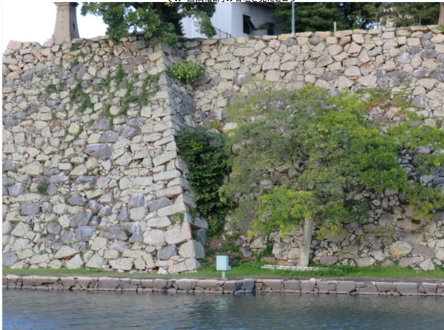
その「西隅櫓跡」の石垣を見たところ
