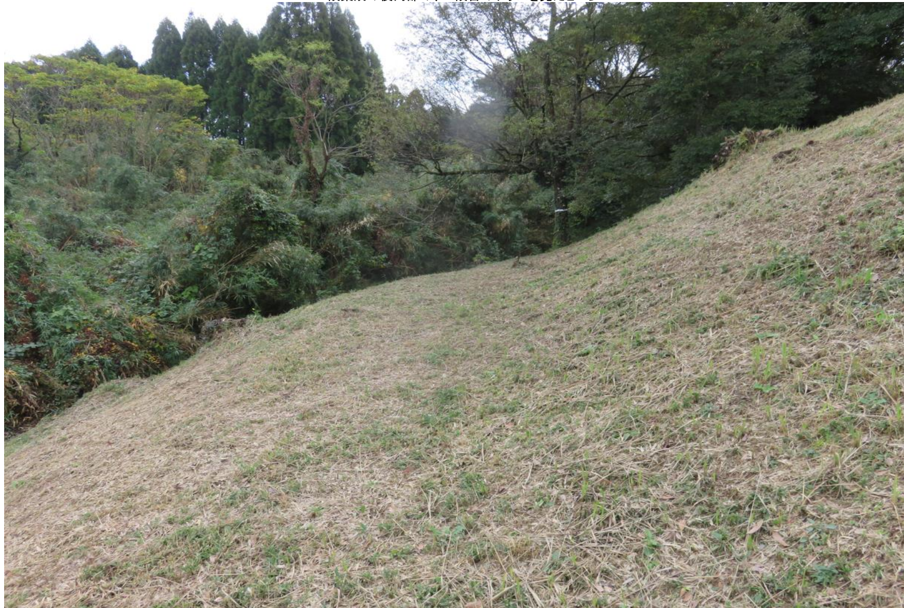
三段築成の後円部の、二段目のテラスを見たところ
