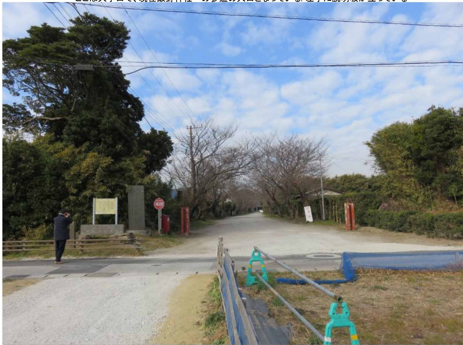
ここは大手口で、現在飯野神社への参道の入口となっている/左手に説明坂が立っている
