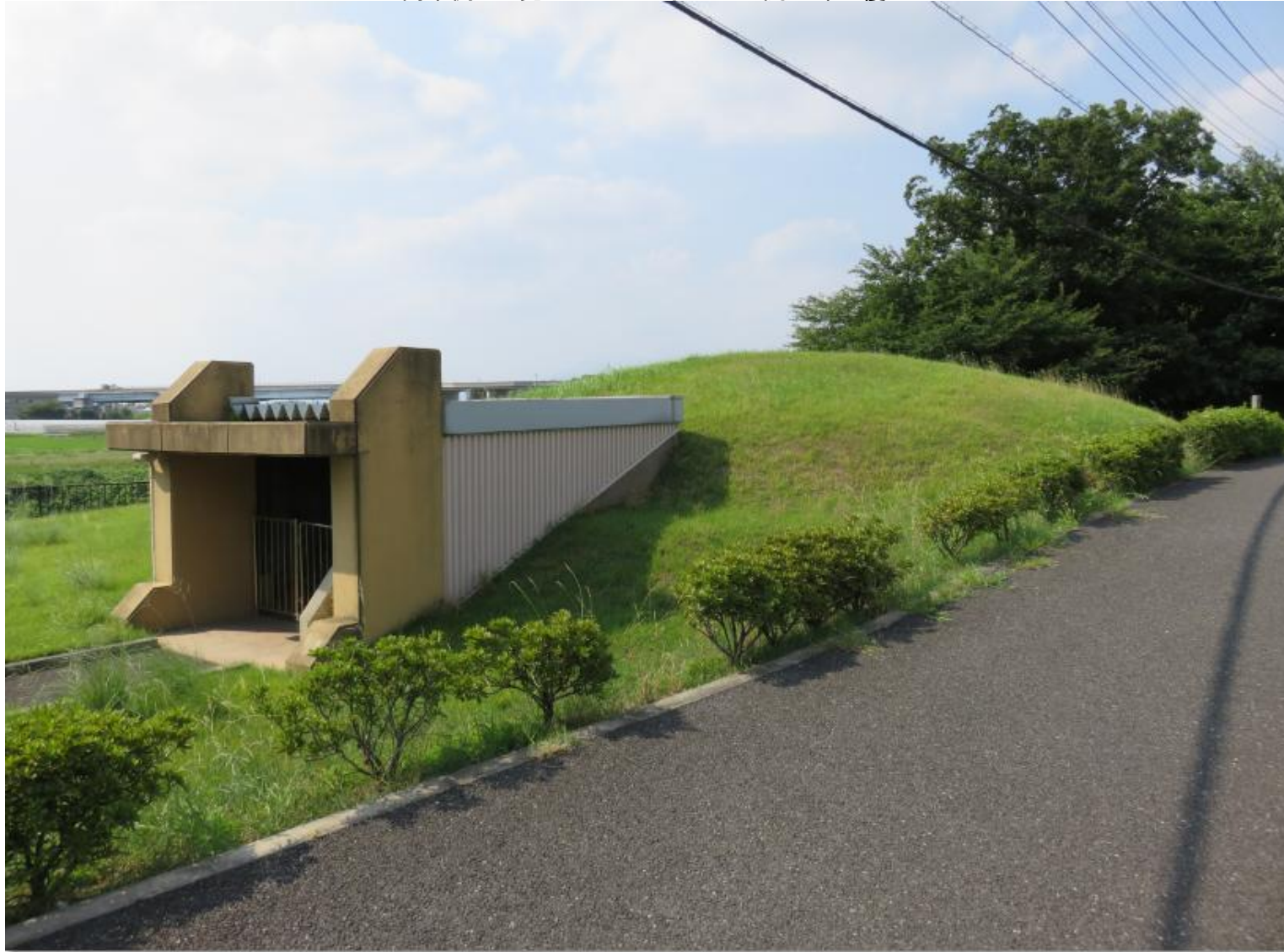
南東側から見たところ/左手が石室開口部の覆屋
