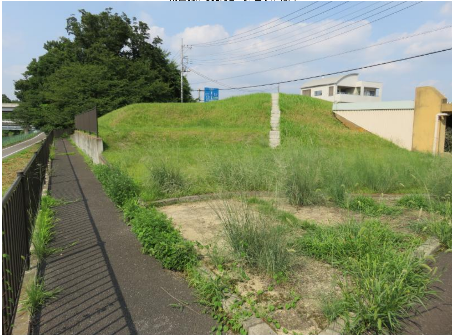
南西側から見たところ/左手が粕川
