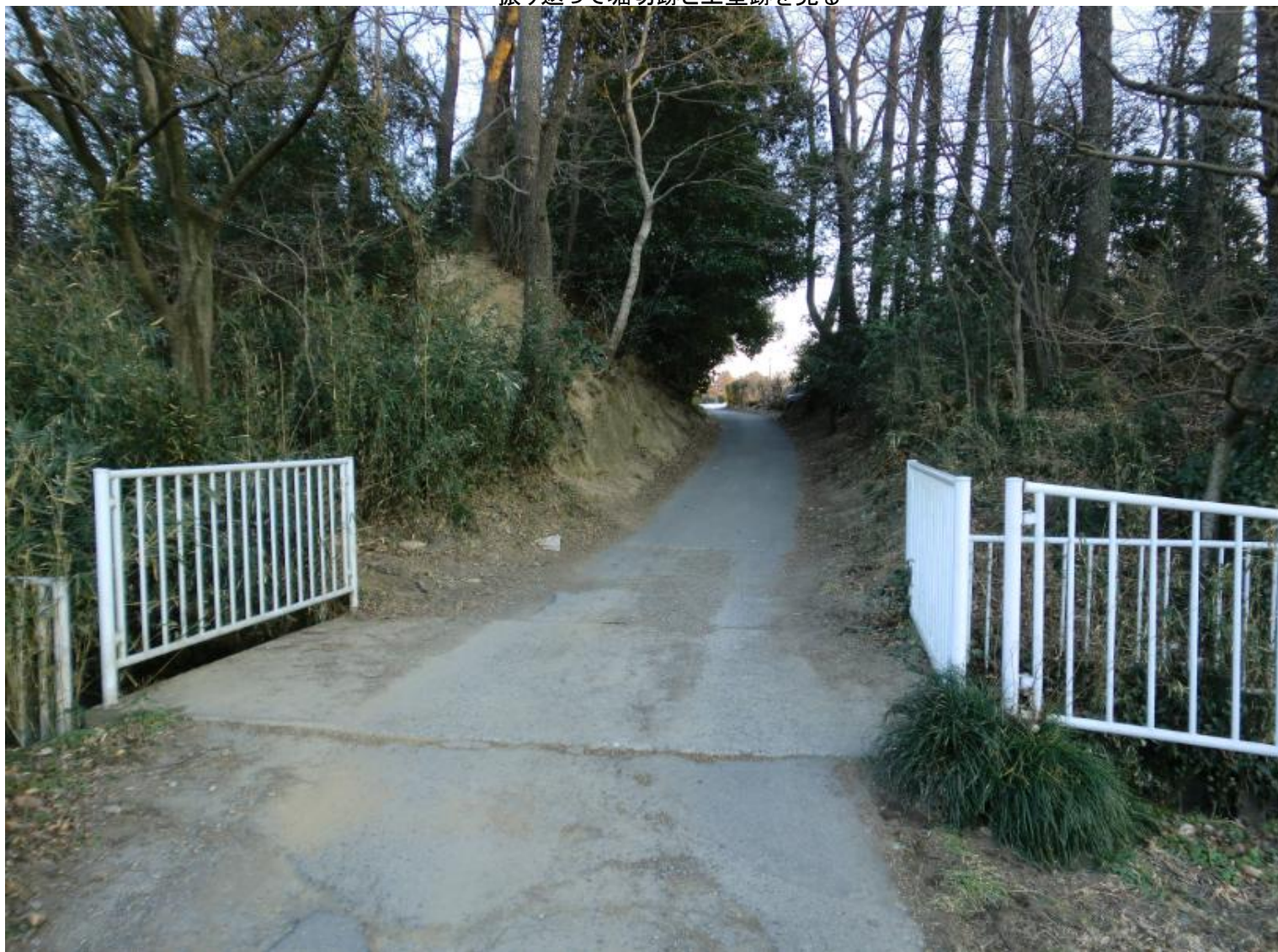
振り返って堀切跡と土塁跡を見る
