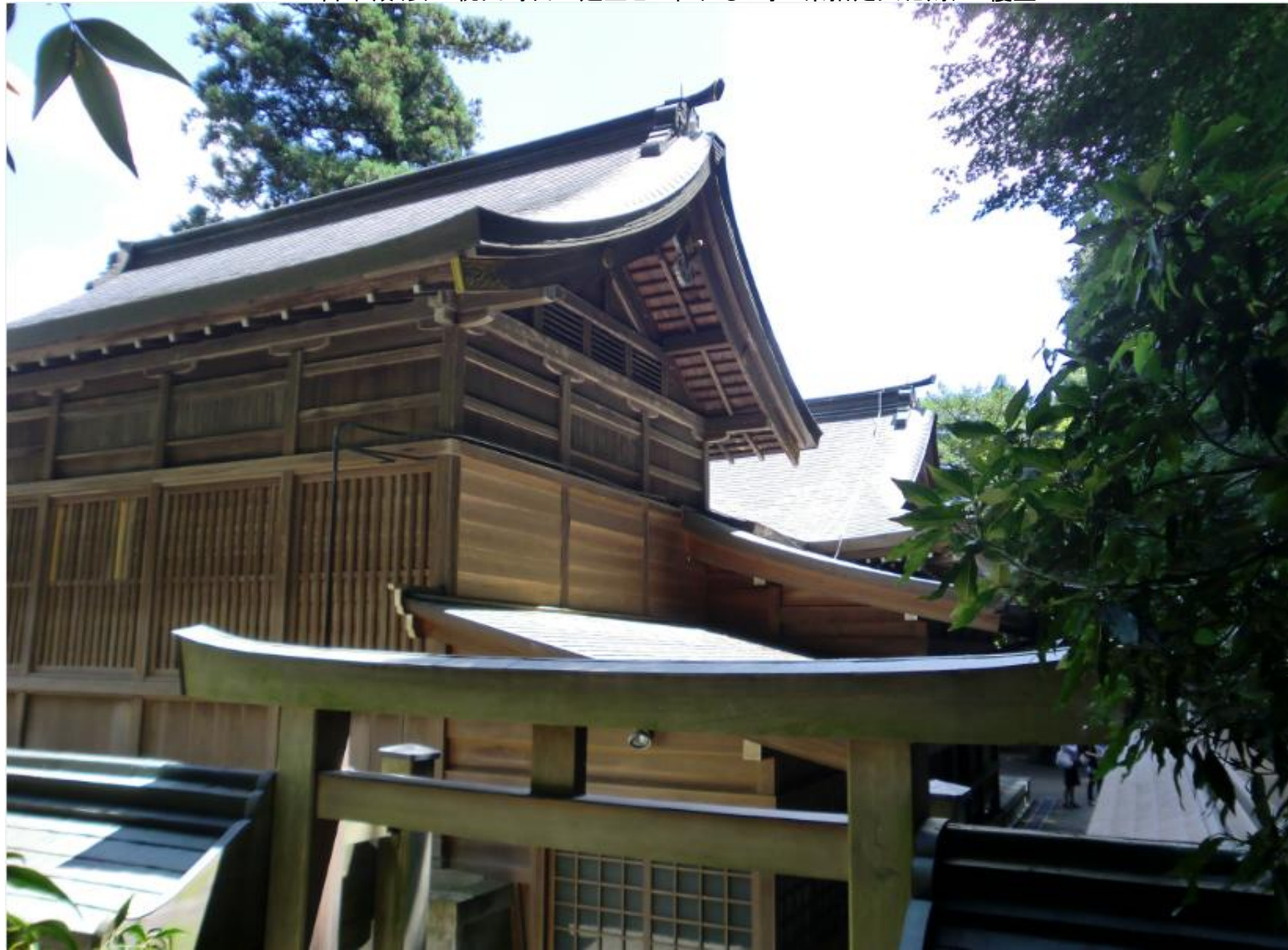
御本殿(安土桃山時代の建立といわれる/埼玉県指定文化財)の覆堂
