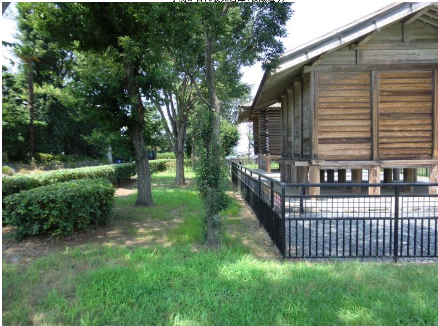
手前が古代復元倉庫(板蔵造り)
