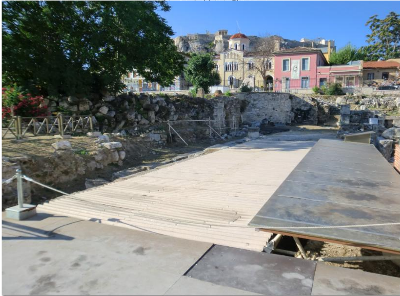
この橋から右手(南方向)を見たところ
