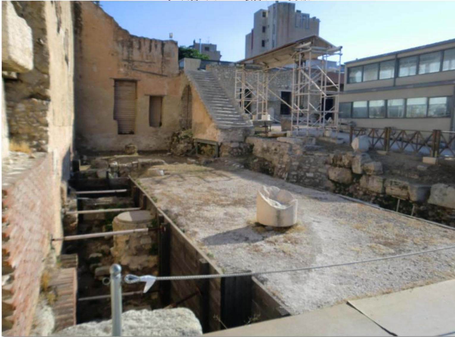
その西側ファサードの裏側はこんな状況
