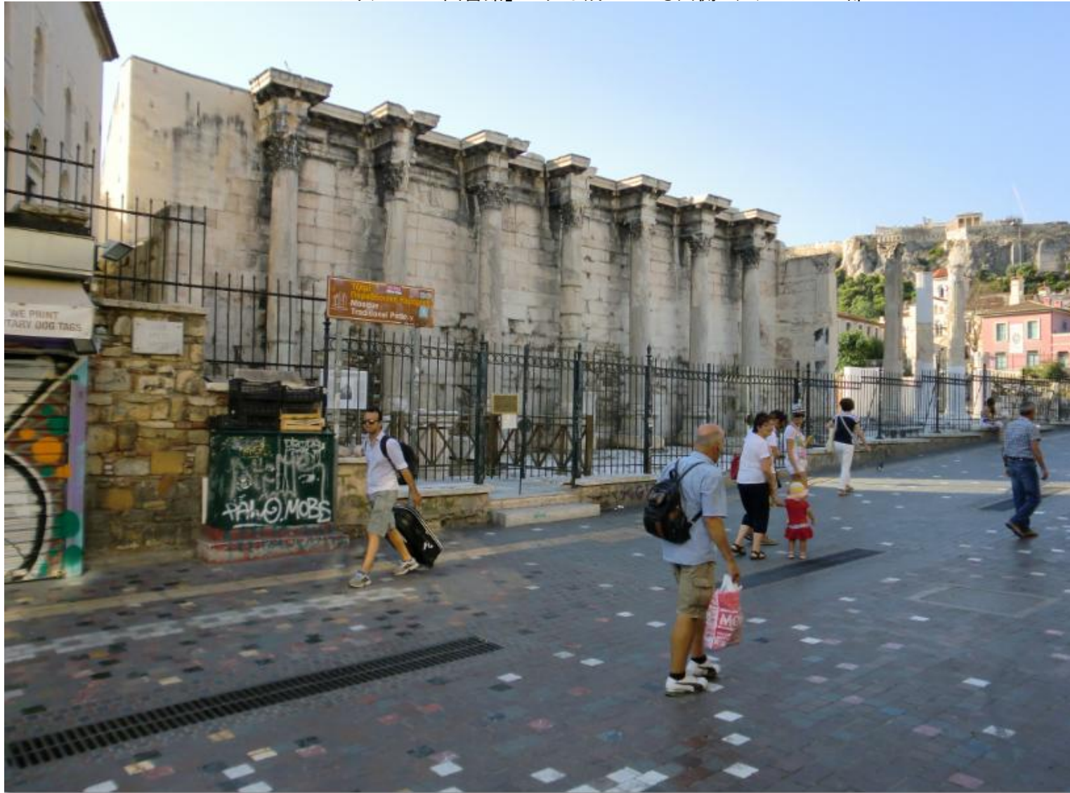
ここが「ハドリアヌスの図書館」/これは残っている西側ファサードの一部
