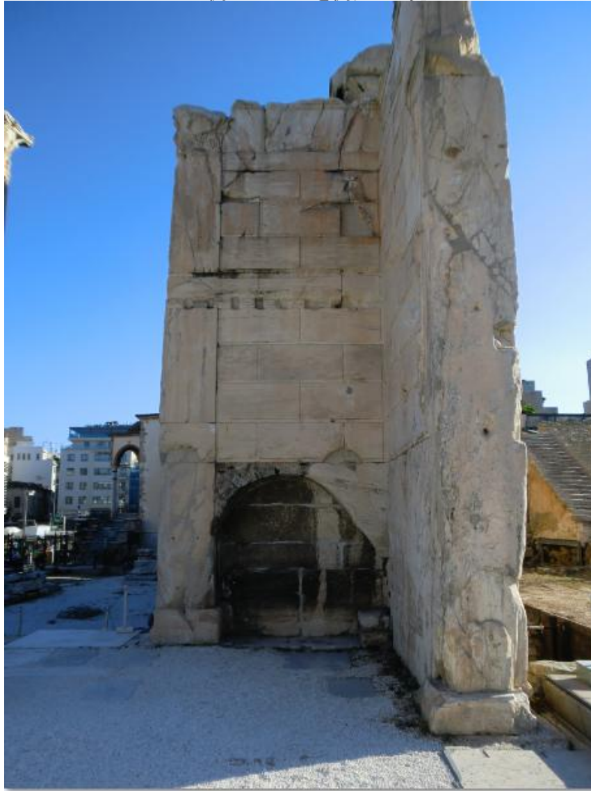
これは西側ファサードを側面から見たところ
