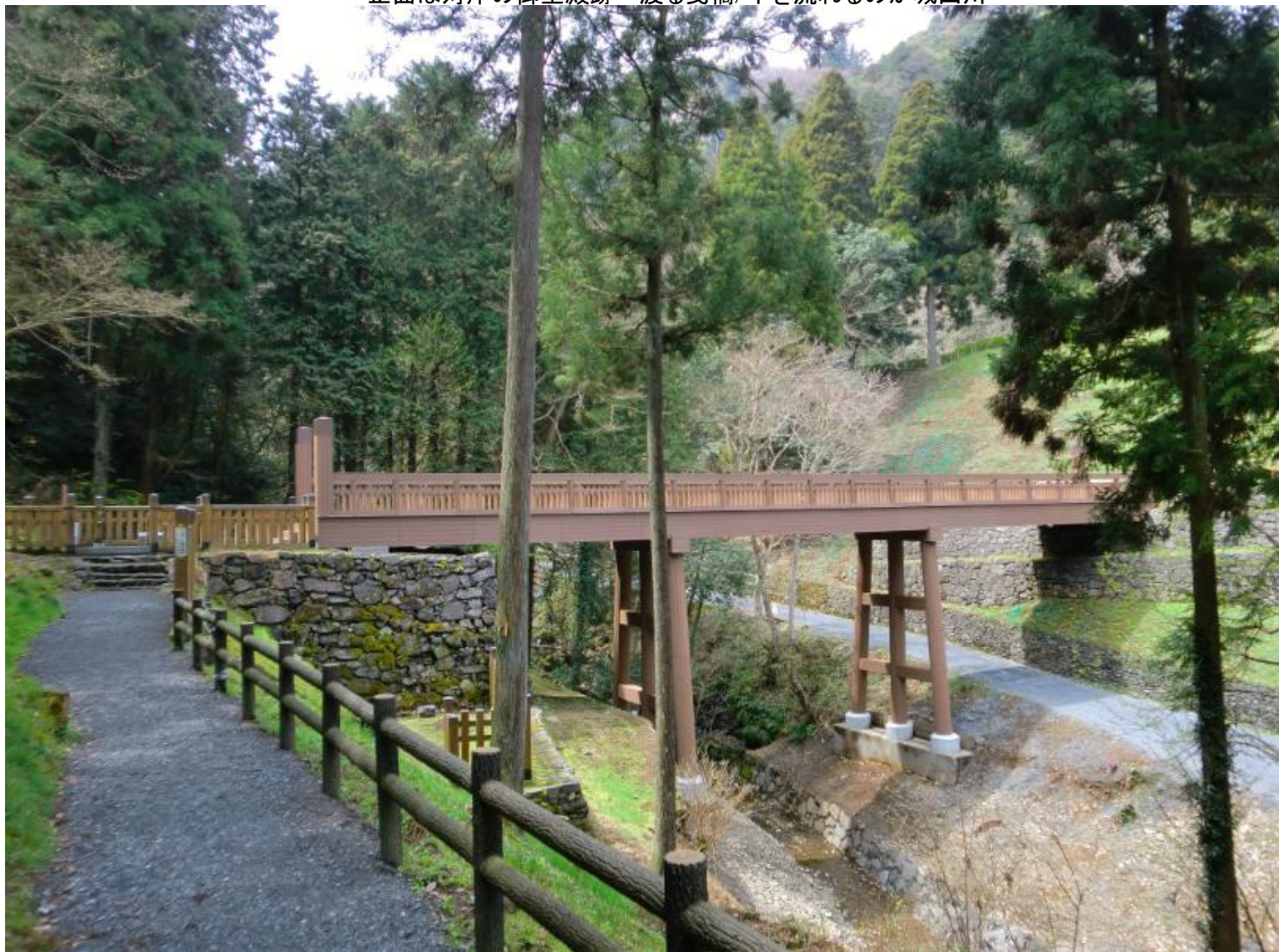
正面は対岸の御主殿跡へ渡る曳橋/下を流れるのが城山川
