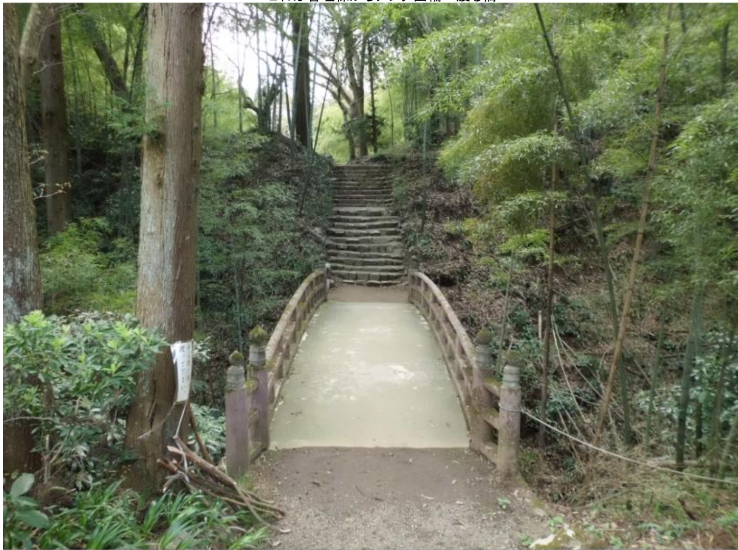
これは管理棟からアシダ曲輪へ渡る橋
