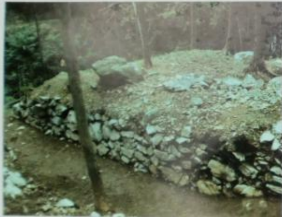
検出した橋台石垣
