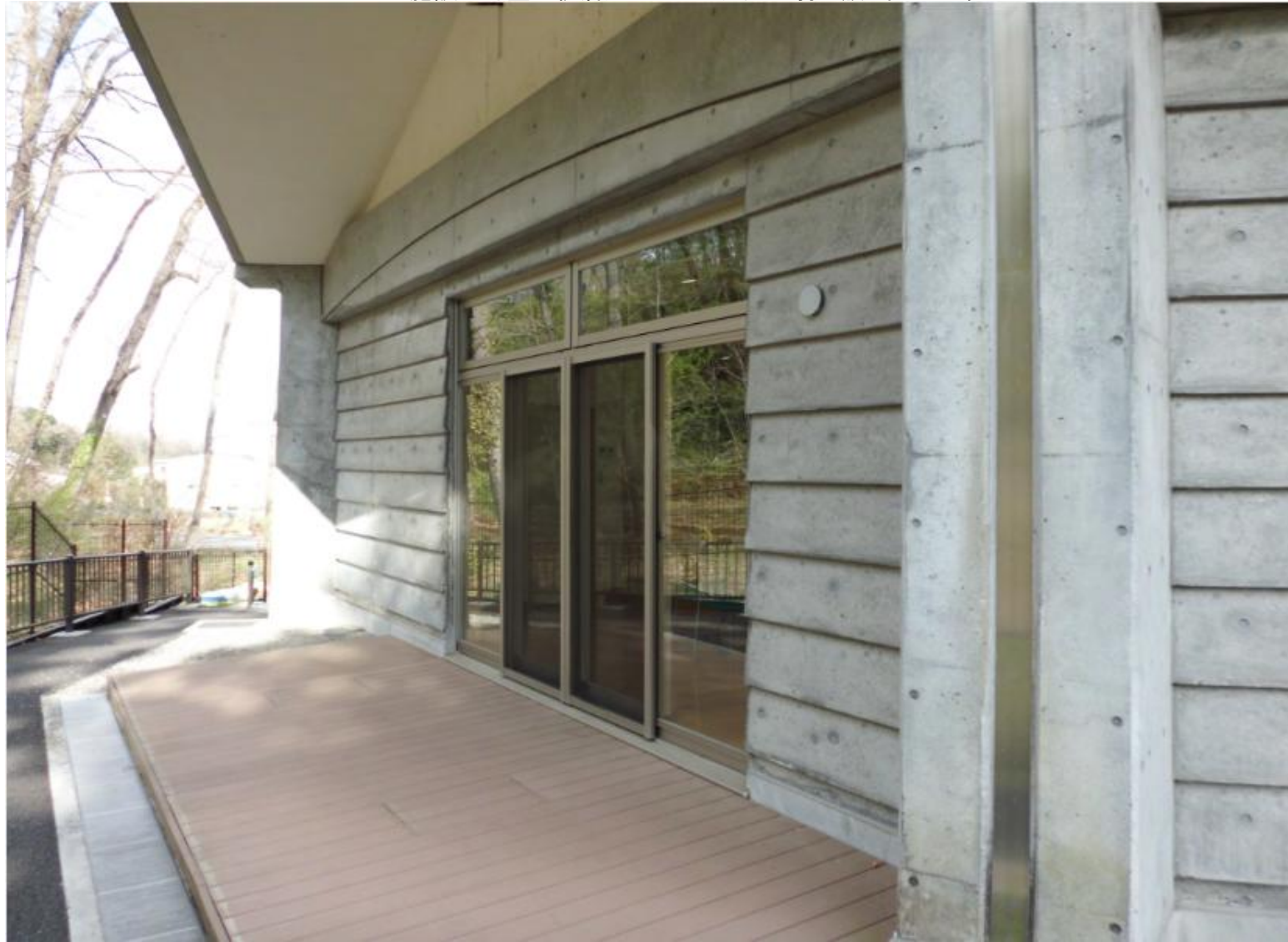
ガイダンス施設の外壁は校倉造風のコンクリート打ち放し仕上げであった
