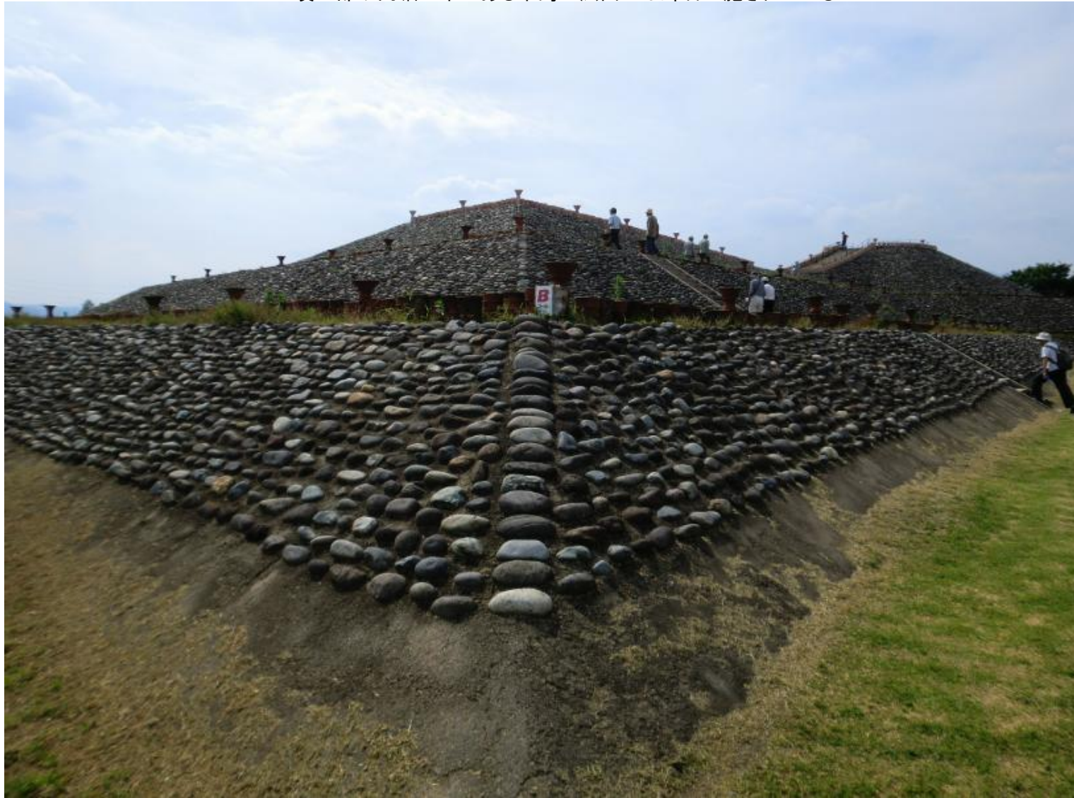
墳丘部や内堀の中にある中島の法面には葺石が施されている
