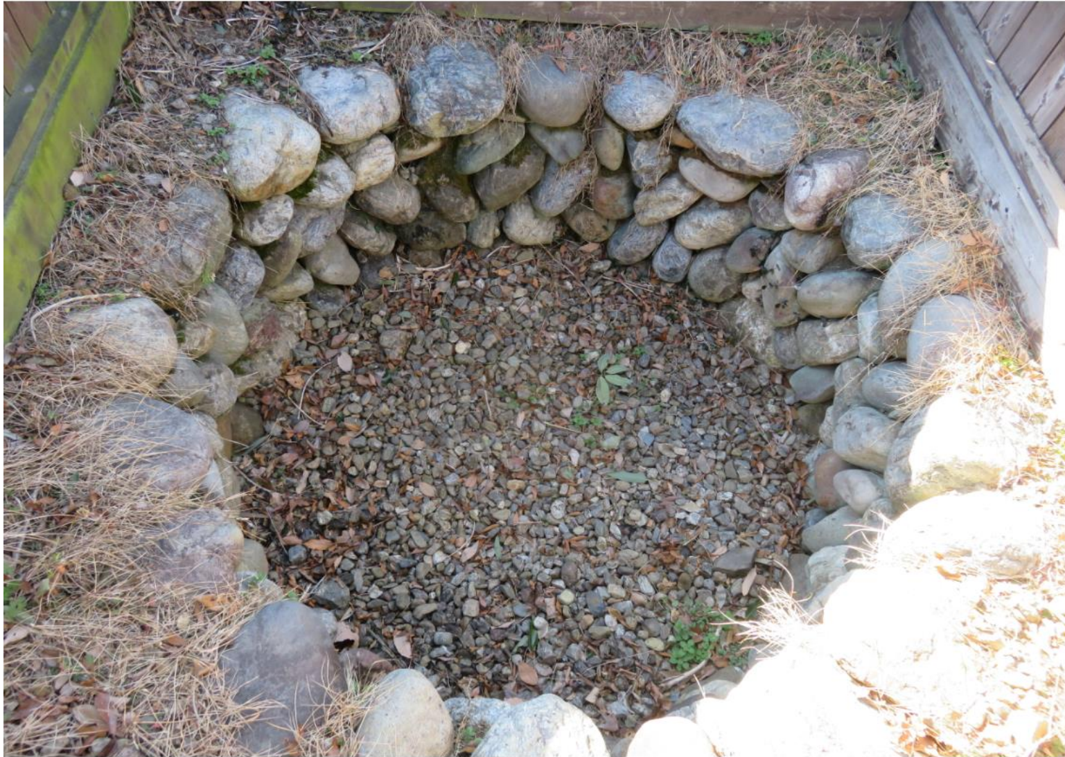
その井戸を覗き込んだところ
