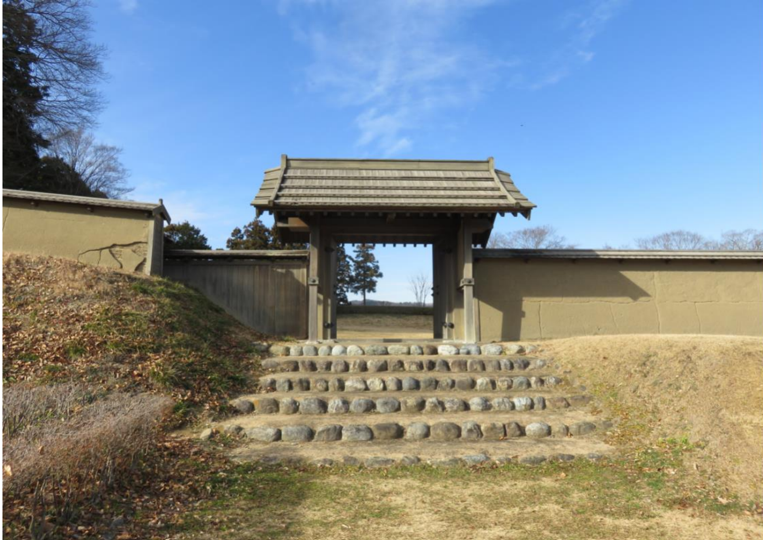
外側から見た四脚門
