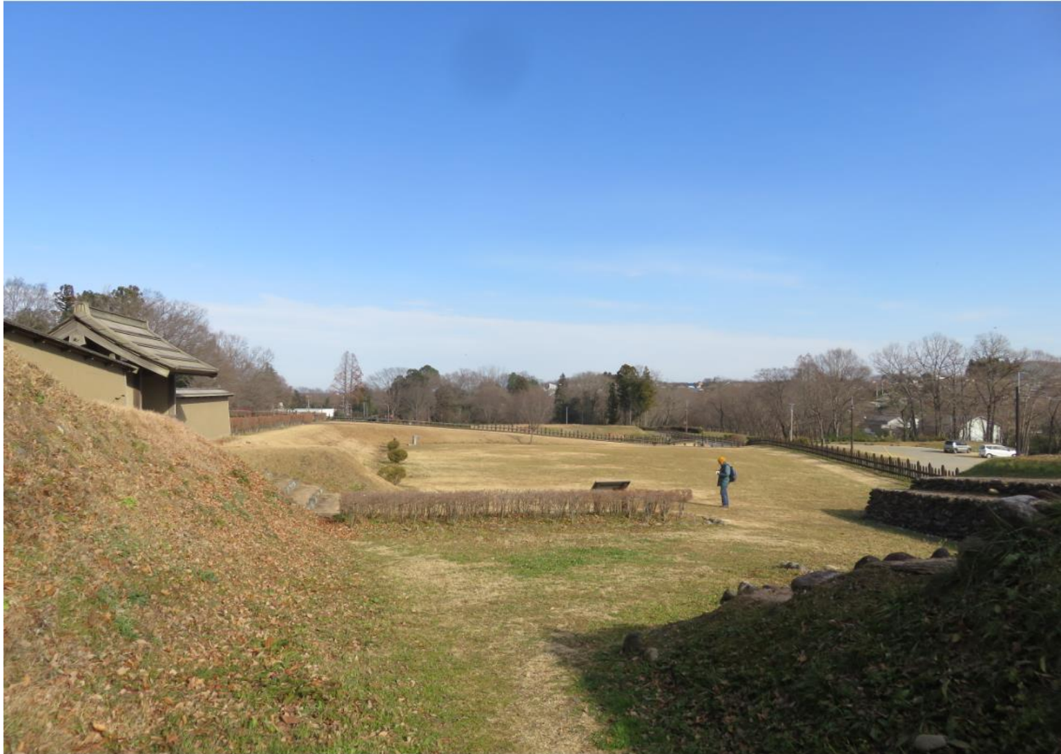
虎口から武者溜りに入ったところ/正面の植栽表示が目隠しの葎
