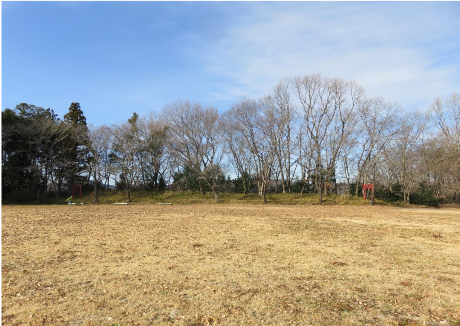
少し退いて、その土塁を見たところ/土塁の背後が荒川
