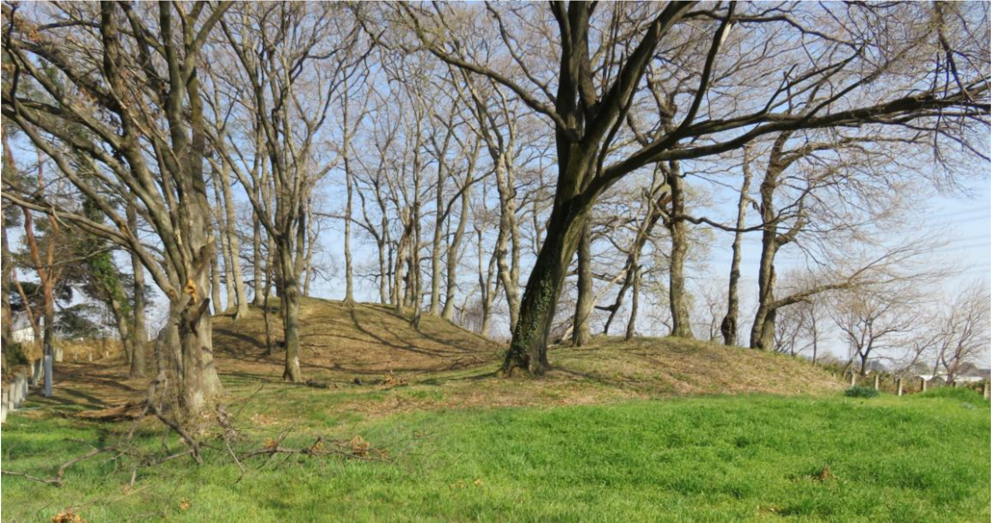
北西側から全景を見たところ
