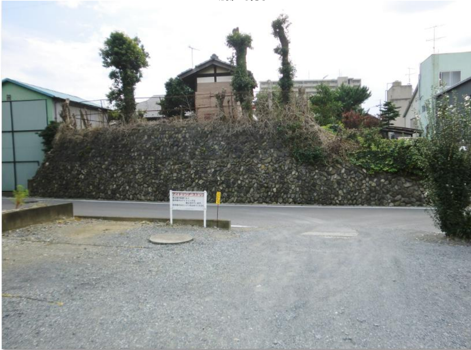
北側から見る
