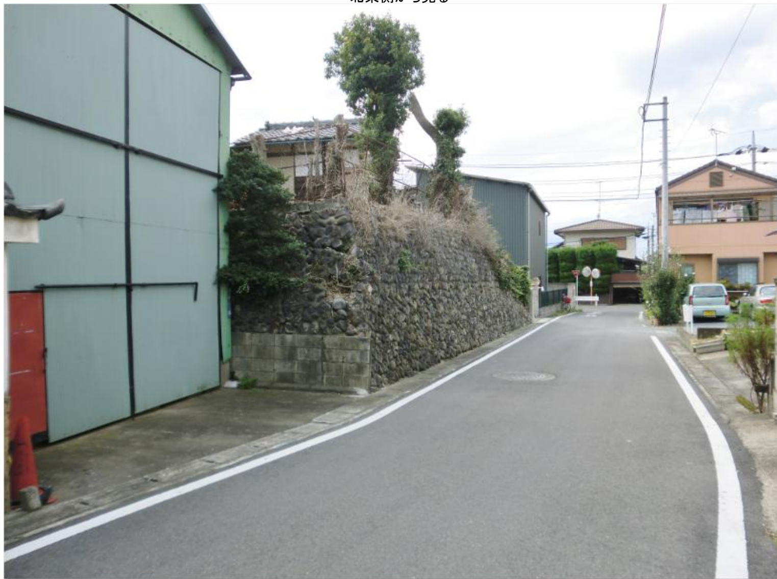
北東側から見る
