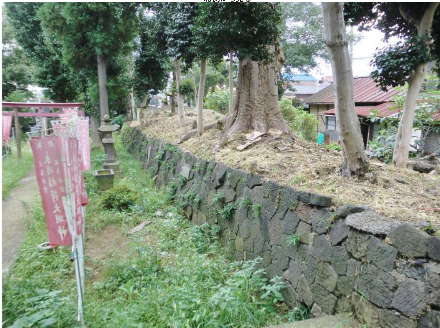
北側から見る
