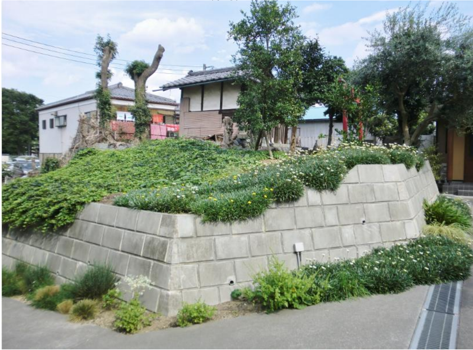
南西側から見る
