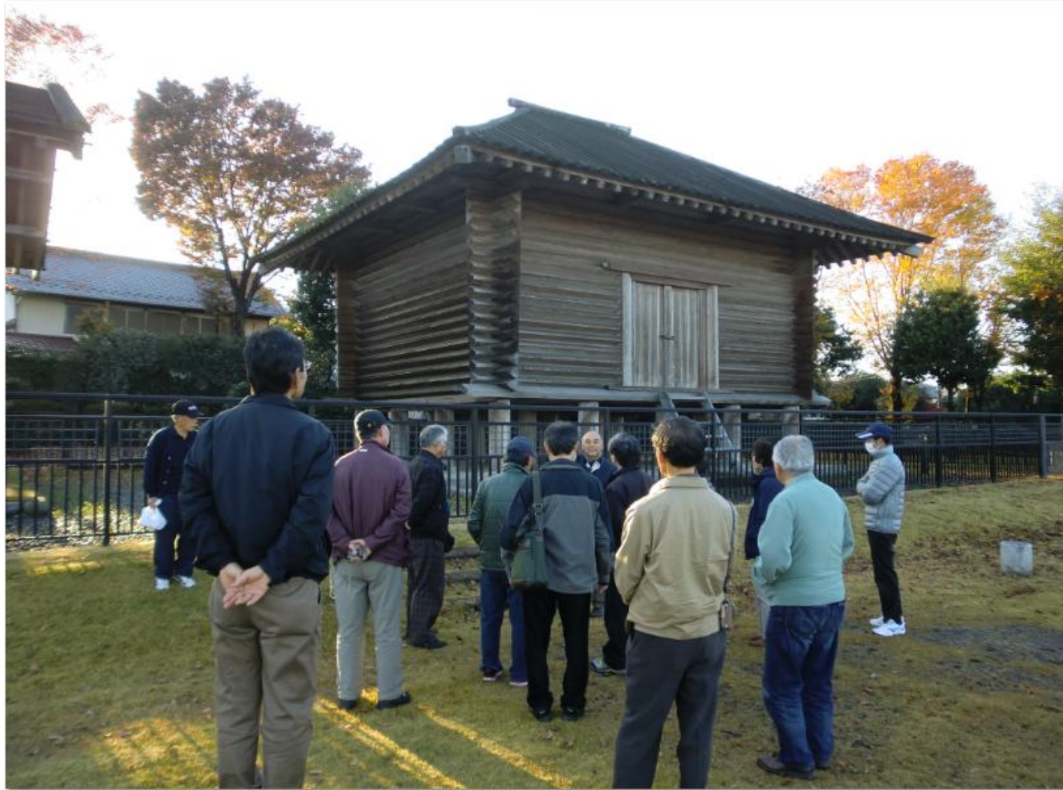
復元された古代復元倉庫(校蔵造り)
