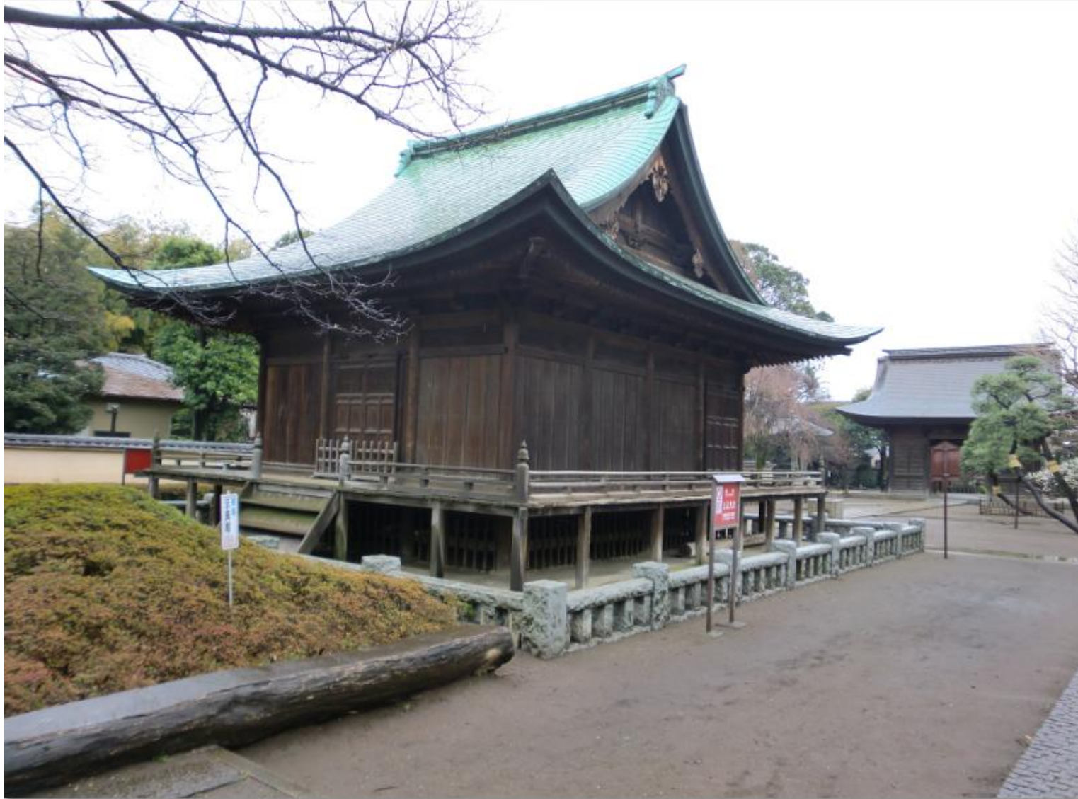
正福寺地蔵堂と同じく屋根の反りが非常に大きい
