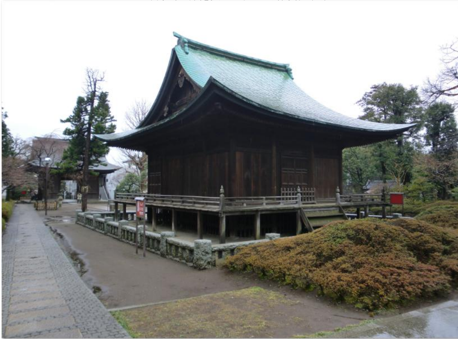
木割が細く、貫を多用した合理的な禅宗様の建築
