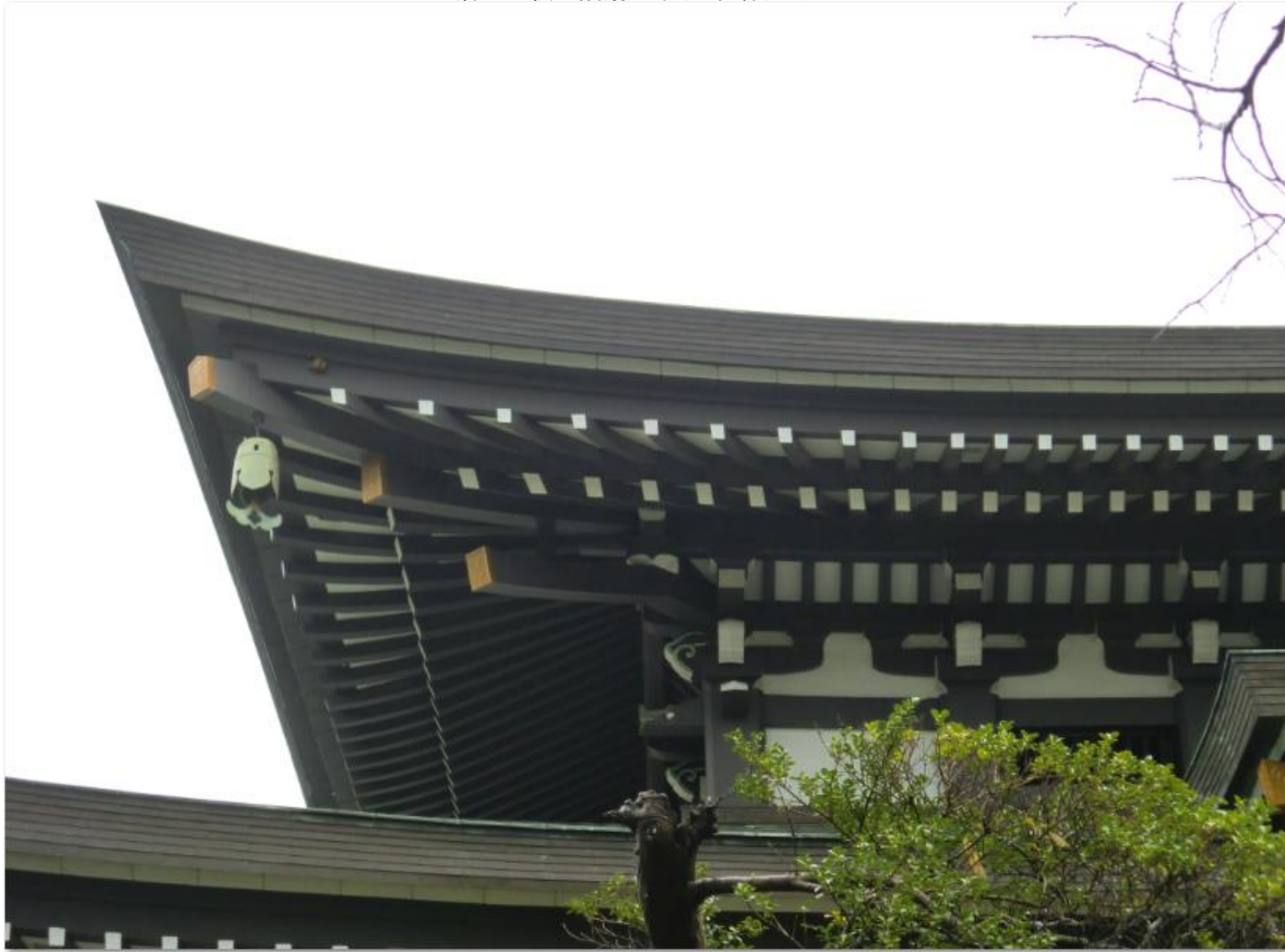
上層の屋根は隅扇垂木(大仏様)となっている
