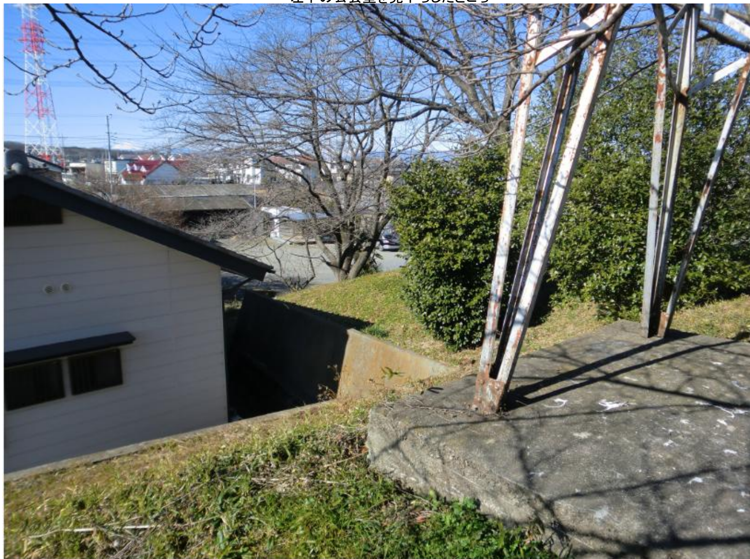
左下の公会堂を見下ろしたところ
