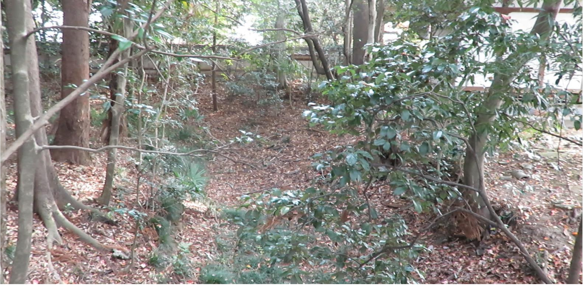
振り返って、南方向を見たところ/築地塀が見える
