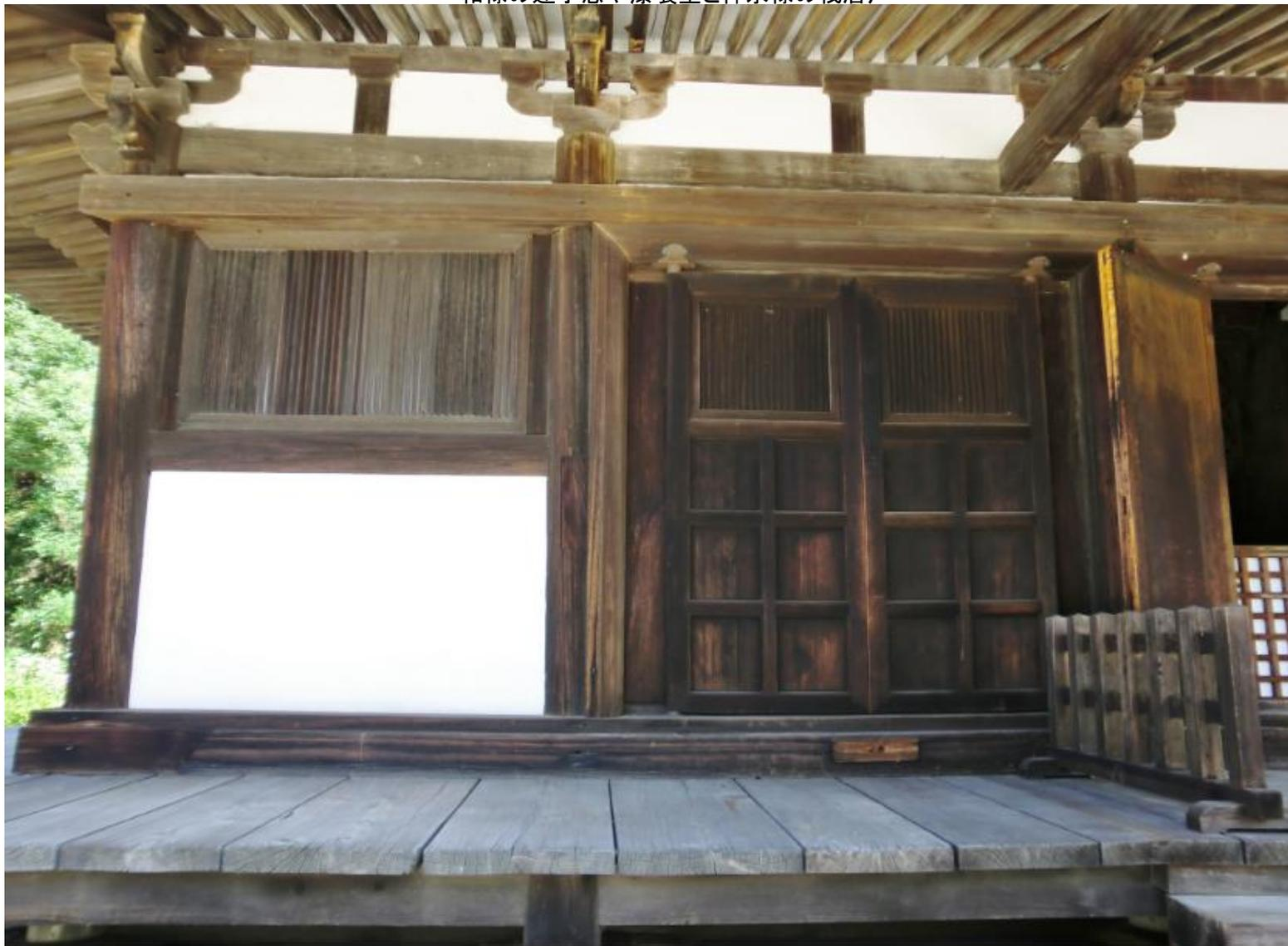
正面の間の両柱のそれぞれ外側で貫に向拝の繋ぎ虹梁が取り付けられている
