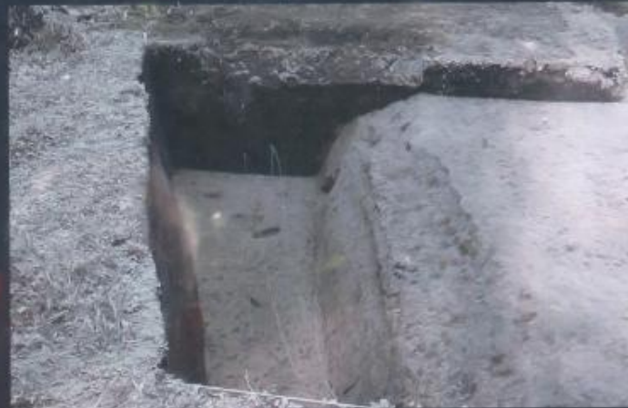
北郭空堀(東から)
