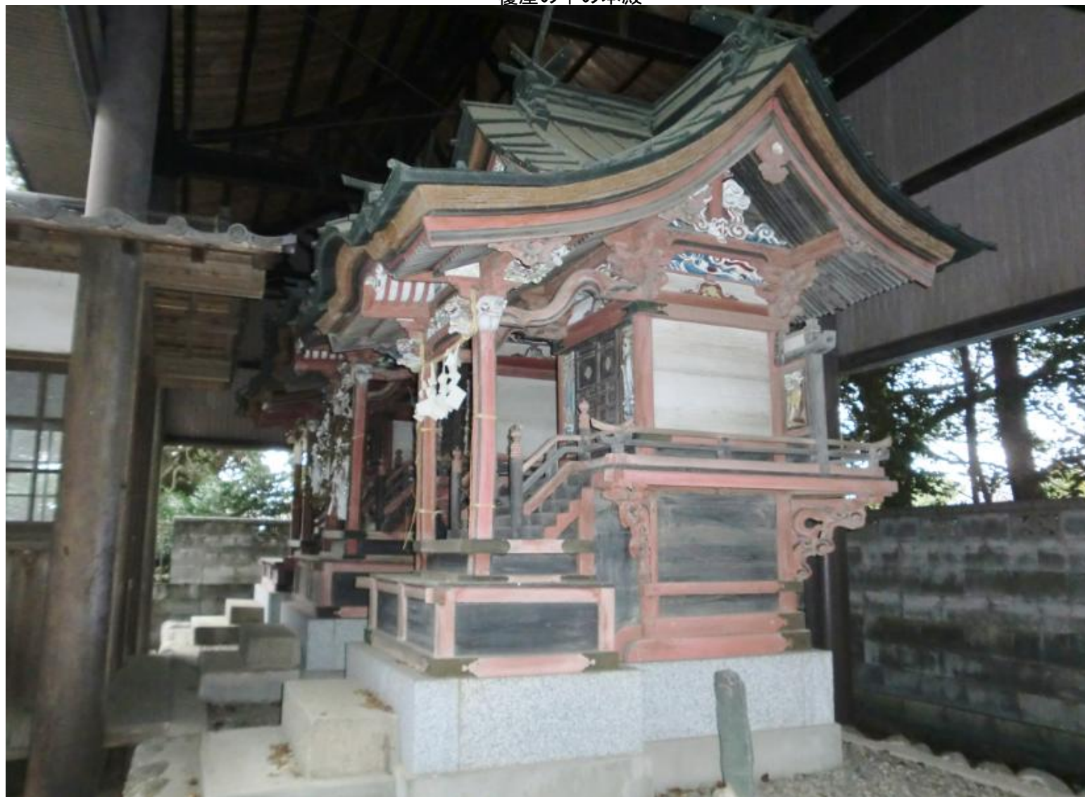
覆屋の中の本殿
