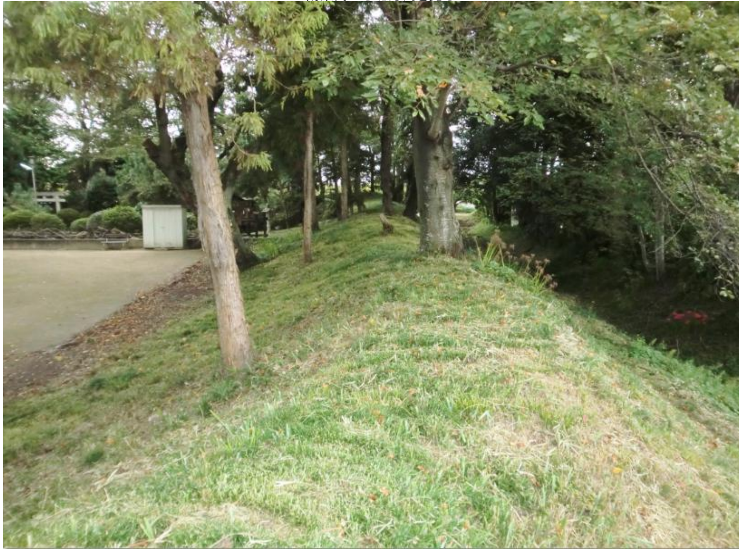
南東角から北方向を見る
