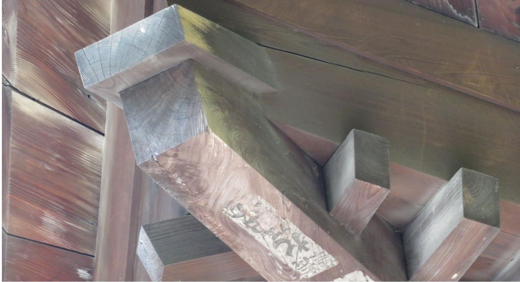
隅木先端部分
