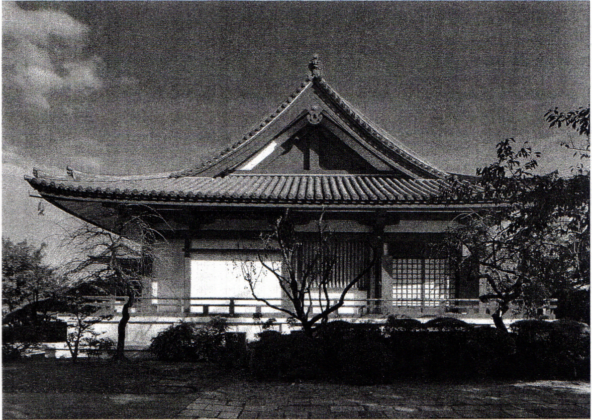
竣工本堂側面全景
