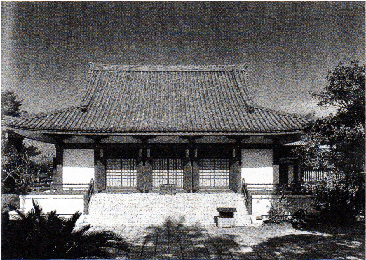
竣工本堂正面全景
