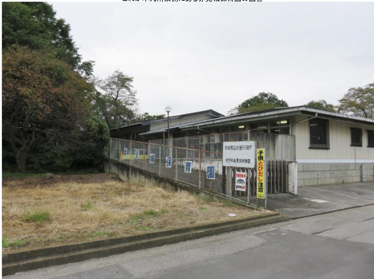
これが本丸南東側にある赤見城保育園の園舎
