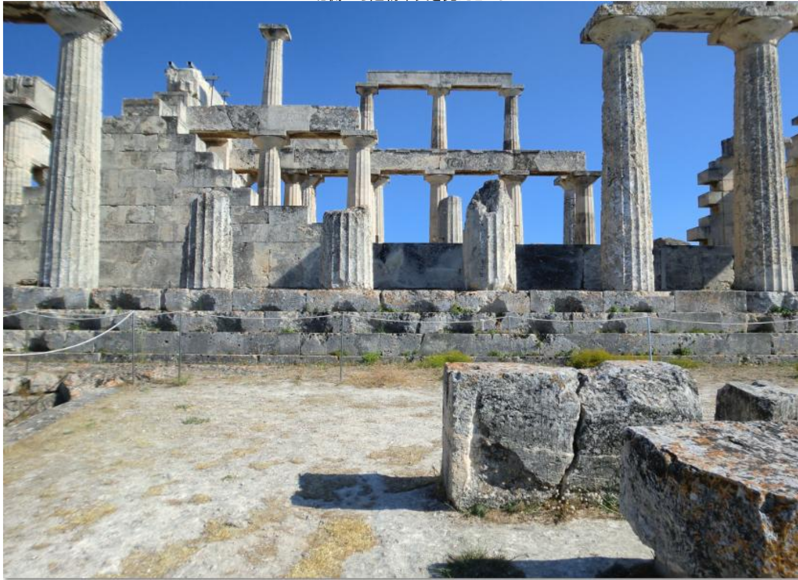
北側から建物中央を見たところ
