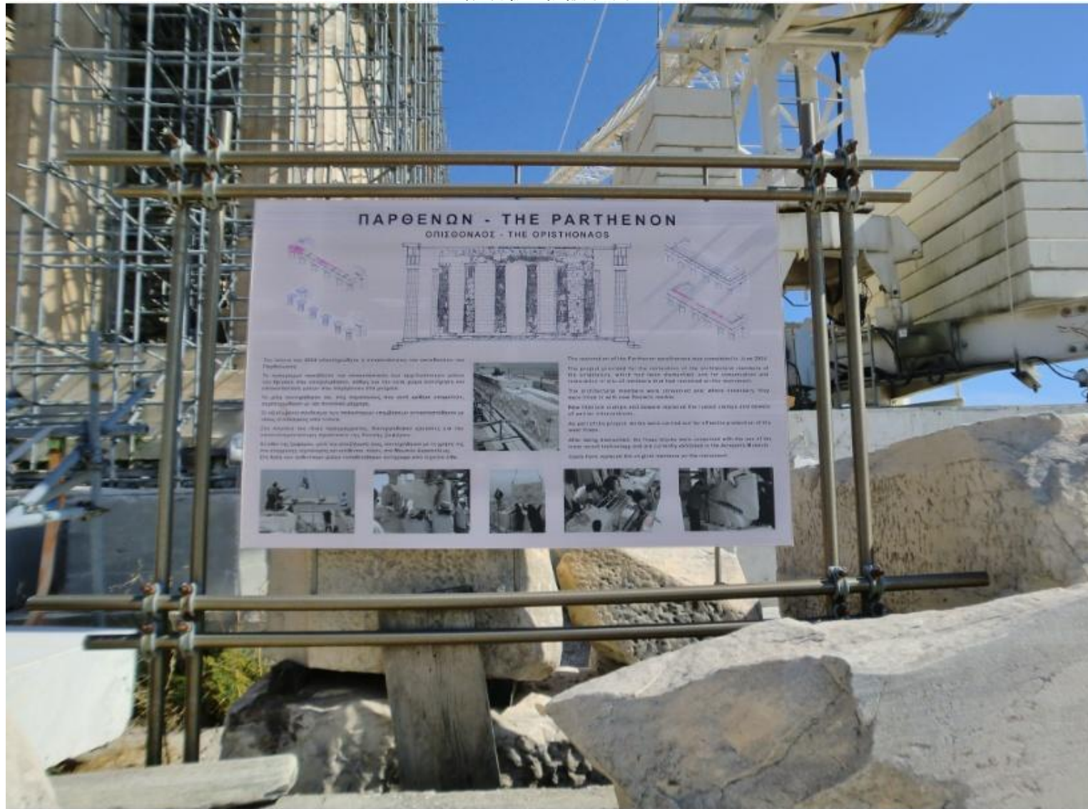
説明板も仮設取り付け
