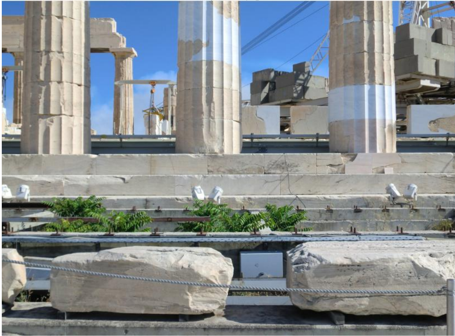
柱足元の状態
