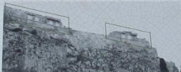
Αρχιτεκτονικά μέλη του ναού ενταχισμένα στο βόρεια τείχος της Ακρόπολης. Architectural members of the temple, incorporated in the north wall of the Acropolis.
