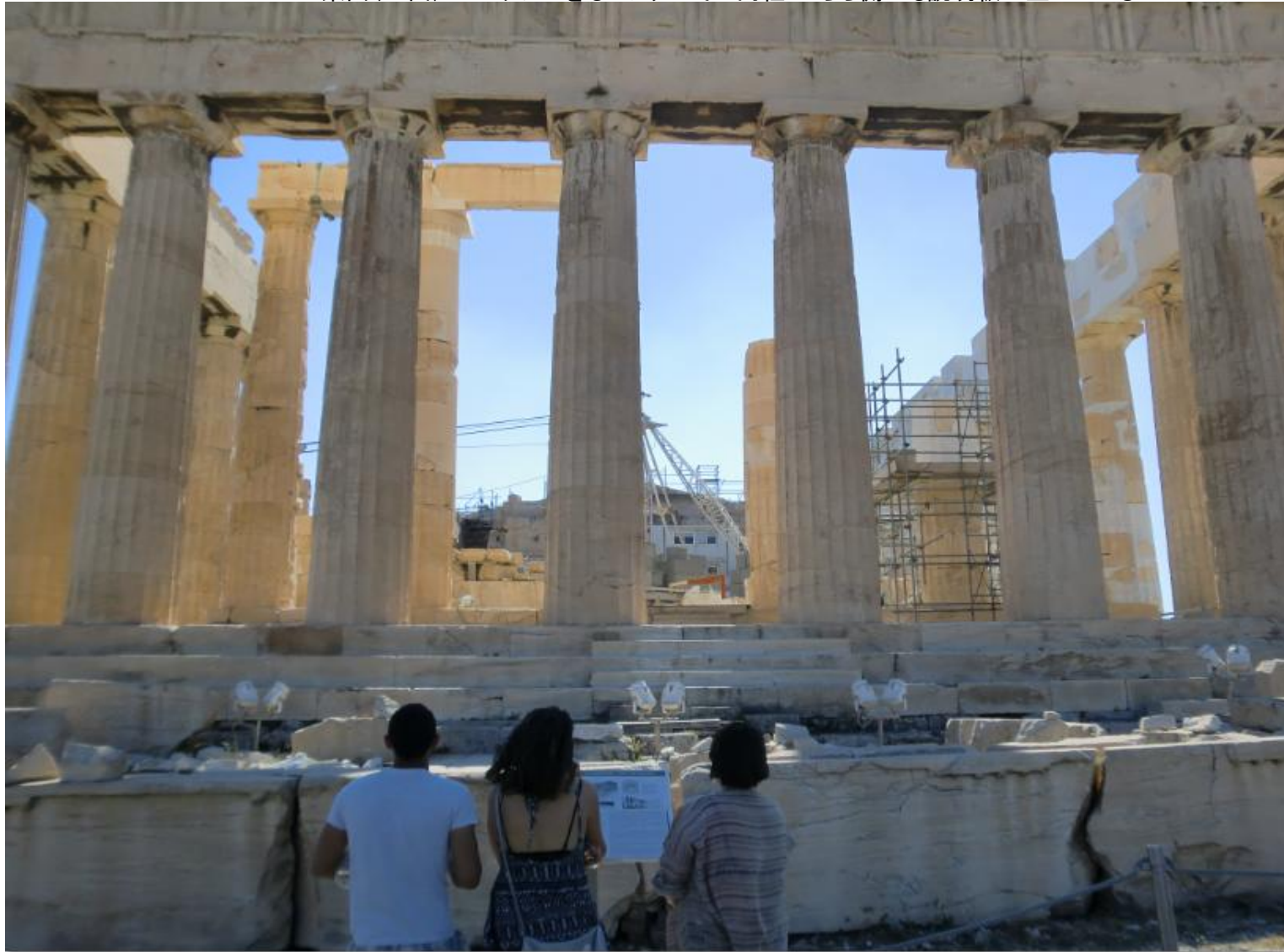
東面(正面)/エンタシスをもつドリス式の円柱/こちら側にも説明板が立っている
