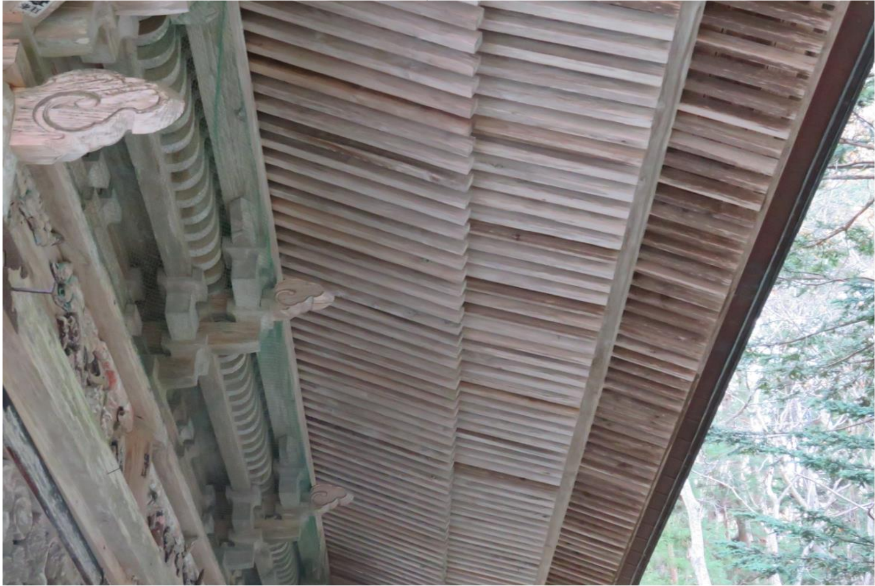
二手先の斗栱と三軒の状況
