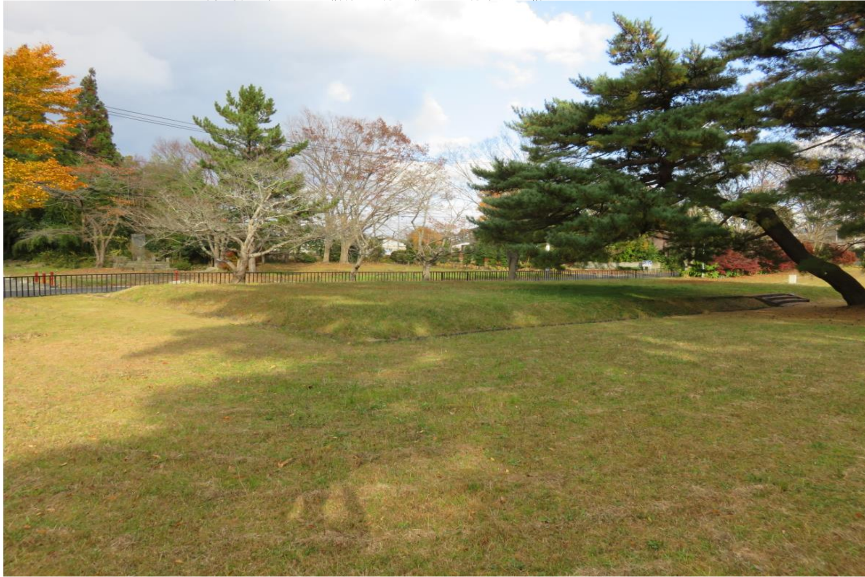
南西側から見たところ/僧房は大房(手前)と小子房(奥)から構成されていたようだ
